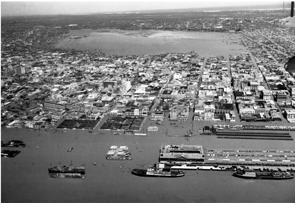
Daños causados por el huracán Hilda. Imagen: Dominio público, 1955.
