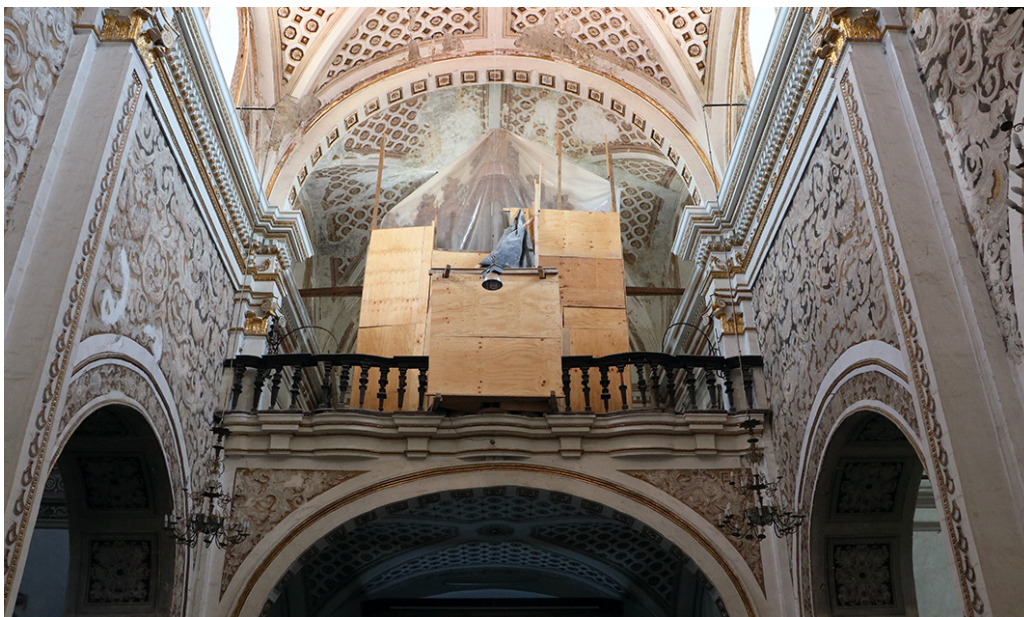
Encofrado de pintura de caballete en la iglesia de Santa Clara, Atlixco, Puebla. Imagen: Oscar Gutiérrez Vargas, ©CNCPC-INAH, 2018.
