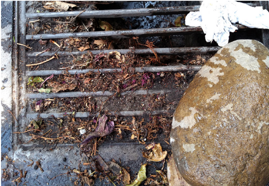
Limpiar desagües, coladeras y alcantarillas. Imagen: ©Marcela Mendoza Sánchez.
