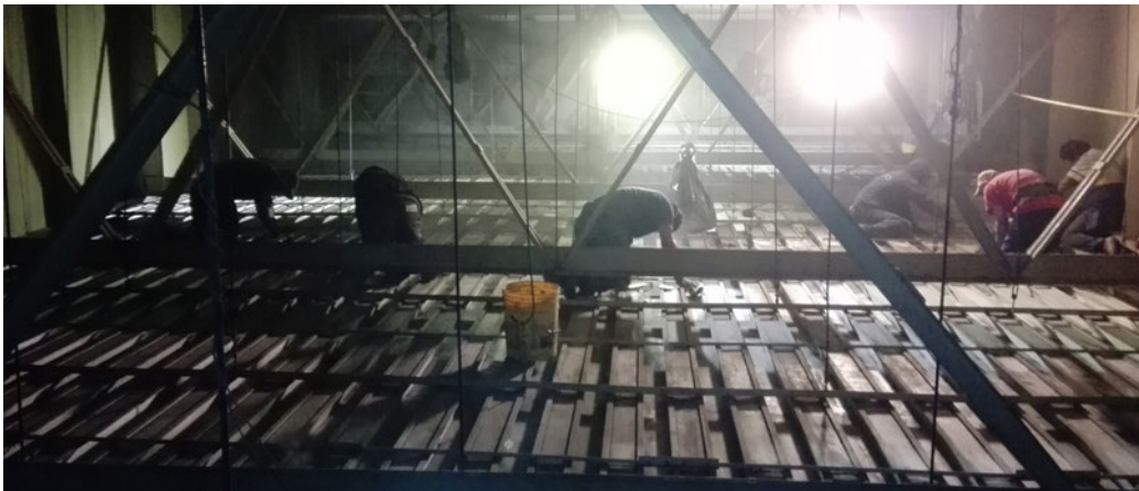
Figura 2. Limpieza y diagnóstico estructural interno del plafón. Imagen: Heriberto Trejo ©MNA-INAH, 2018.
