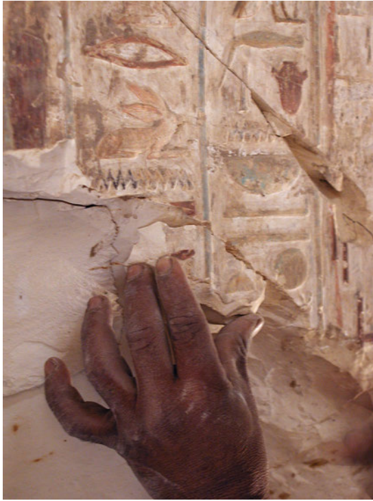
Figure 4. Example of damage in the tomb. Image: ©Misión Mexicana en Egipto CNCPC-INAH.
