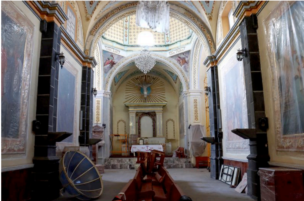
Figura 1. Interior del templo con protecciones. Imagen: ©CNCPC-INAH, 2021.
