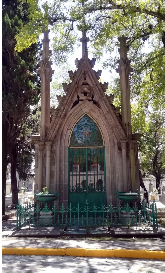
Figura 2. Fachada principal del mausoleo Conde y Morales, siglo XIX. Imagen: ©Luis Eduardo Gutiérrez García, 2021.
