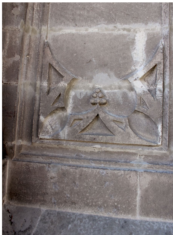
Figura 11. Detalle de rejunteos en fachada de mausoleo Bello. Imagen: ©Luis Eduardo Gutiérrez García, 2021.
