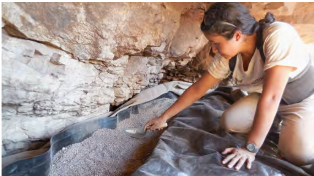
Figura 15. Colocación del relleno de granulometría media en el sistema de reenterramiento del abrigo con pinturas rupestres. Imagen: Sandra Cruz Flores, ©CNCPC-INAH, 2016.
