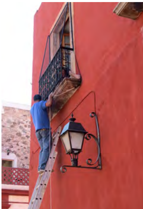
Figura 2. Fijado de la malla antipájaro en uno de los balcones de la Sala 4 de la Biblioteca Histórica. Imagen: Rosario Bravo, ©INAH.
