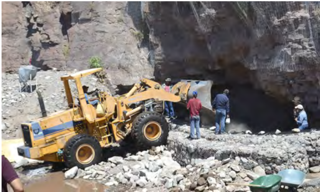
Figura 14. Depósito del relleno de granulometría gruesa en el sistema de reenterramiento confinado por gaviones. Imagen: Angélica Vásquez Martínez, ©CNCPC-INAH, 2016.
