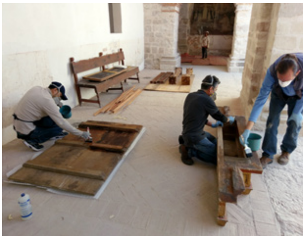
▲ Figura 4. Fumigación por impregnación de componentes del retablo de santa Gertrudis, San Pedro y San Pablo Teposcolula, Oaxaca. Foto: Christian Chávez González | © Acervo CNCPC - INAH.
