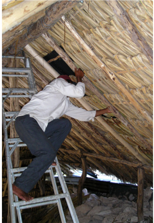
▲ Figura 8. Colocación de palma de guano para techumbre, Ek Balam, Yucatán. Foto: Alejandra Alonso | © Acervo CNCPC - INAH.
