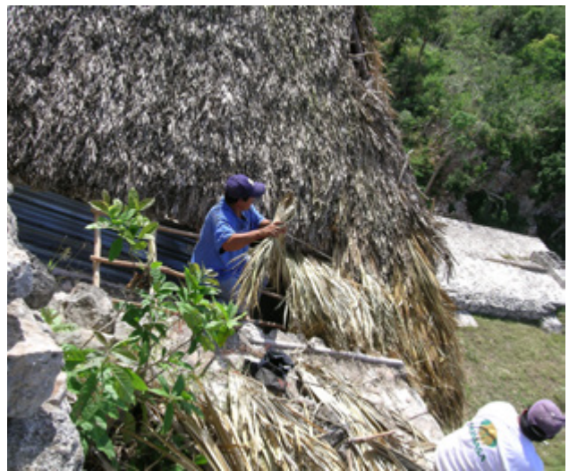
▲ Figura 9. Colocación de palma de guano para techumbre, Ek Balam, Yucatán. Foto: Alejandra Alonso | © Acervo CNCPC - INAH.
