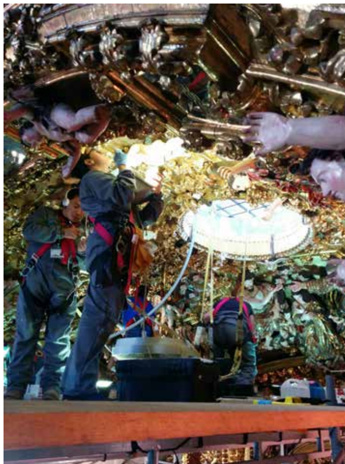
▲ Proceso de resane en la bóveda del retablo de la Virgen de Ocotlán. Centro INAH Tlaxcala | © INAH, 2014.
