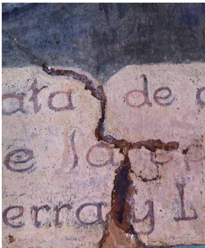
▲ Detalle de fractura del panel. CNCPC | © INAH, 2015.
