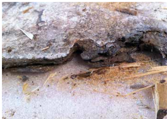
▲ Ataque de carcoma en travesaño. CNCPC | © INAH, 2015.
