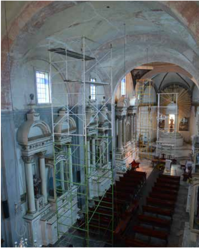
▲ Interior del templo. CNCPC | © INAH, 2015.
