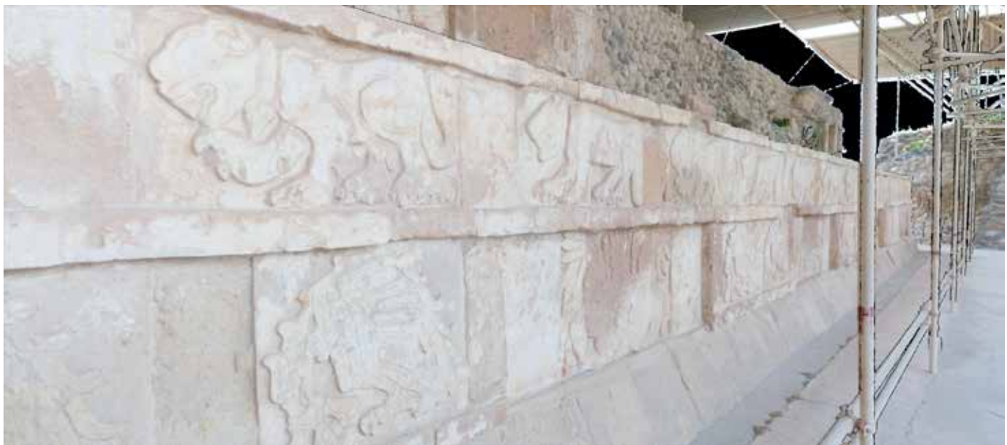
▲ Figura 6. Vista perspectiva de la Fachada Este en nube de puntos con fotografía integrada. CNCPC | © INAH, 2015.
