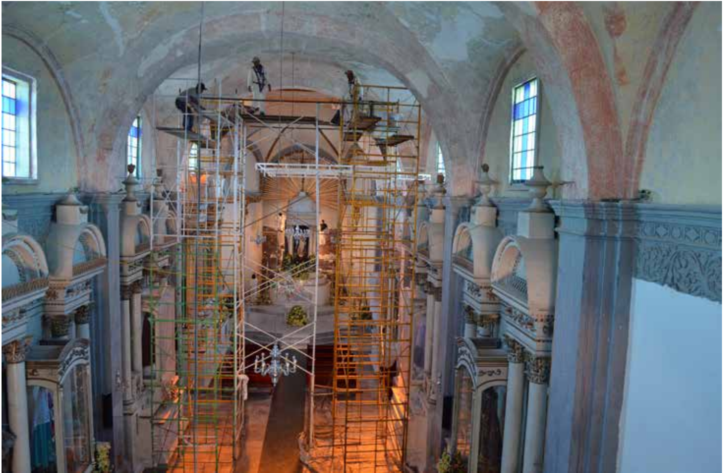
▲ Trabajos de restauración en la bóveda principal del templo. CNCPC | © INAH, 2015.
