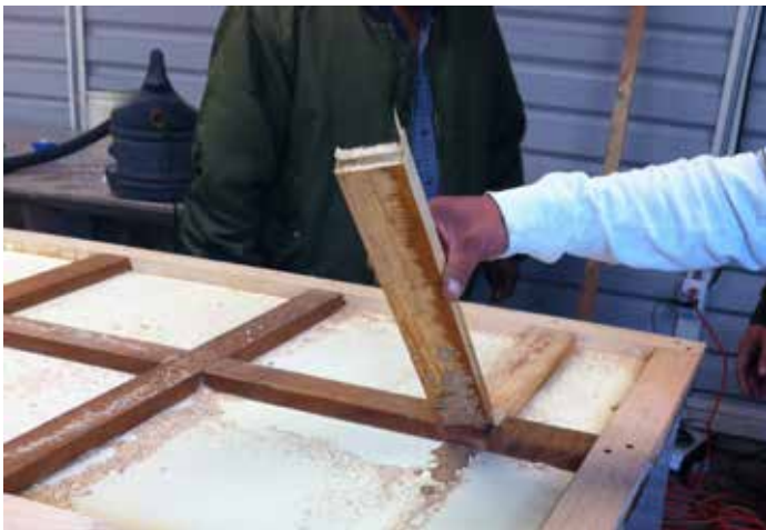
▲ Eliminación de travesaño atacado. CNCPC | © INAH, 2015.
