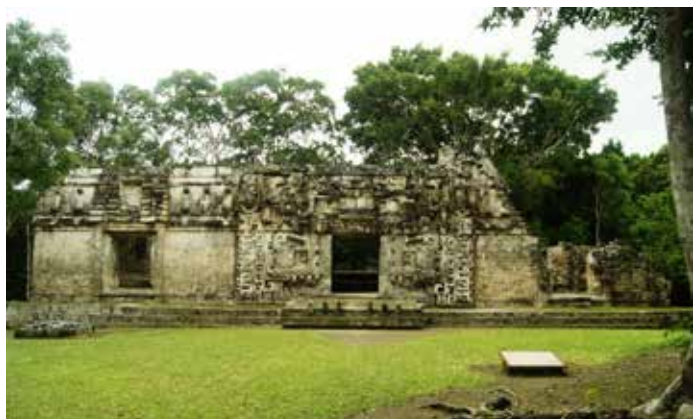
▲ Vista general de la fachada zoomorfa de la estructura II de Chicanná. CNCPC | © INAH, 2014.
