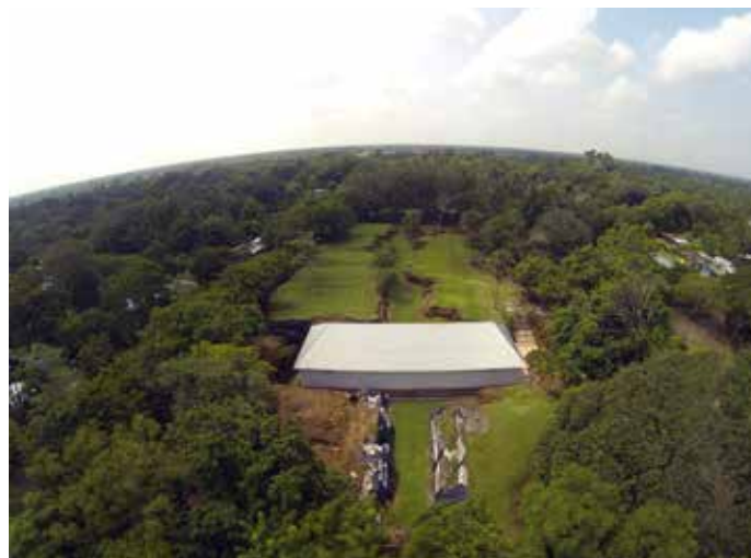
▲ Figura 6. Vista general aérea, toma realizada desde el norte (Jaime Hernández Mercado) | © INAH, 2014.
