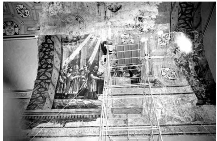
▲ Foto en el momento de eliminar la decoración del siglo XIX para descubrir la original del siglo XVI. A los lados, pintura falsa reciente. Fototeca CNCPC | © INAH, ca. 1946-1967
