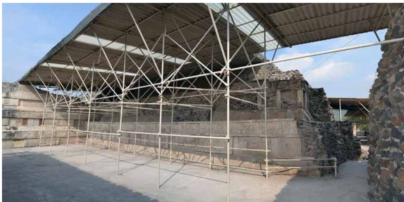
▲ Figura 1. Vista general de la Fachada Este de la Estructura B. CNCPC | © INAH, 2015.
