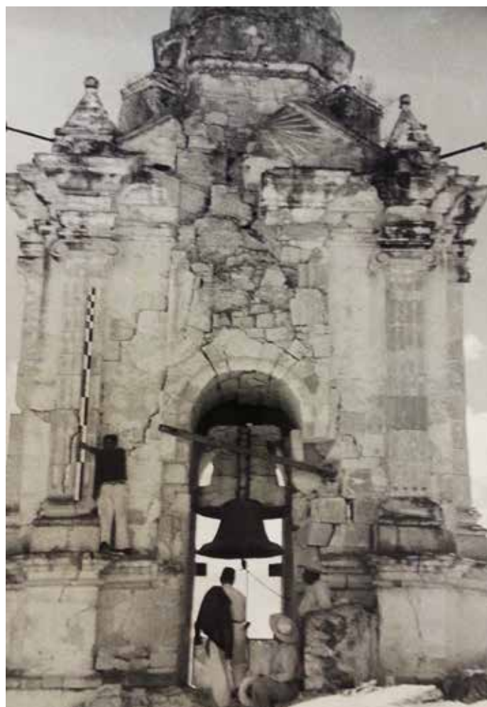
▲ Fig. 6 Torre antes de la restauración de 1957 (ACNMH. Exp. San Juan Bautista de Coixtlahuaca. Leg. 5. s/f.). Aunque la fotografía se encuentra entre los documentos fechados en 1973, la imagen debió tomarse después de 1943, tras el terremoto del 22 de febrero de ese año y, en todo caso, antes de la restauración de 1957. Probablemente hacia 1949, de acuerdo a otra imagen similar fechada en ese año y resguardada en la fototeca de la CNMH | © INAH.
