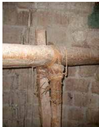
◀ Revisión de amarres para entender el sistema constructivo y reproducirlo apegándonos al original. | © INAH, 2000.
