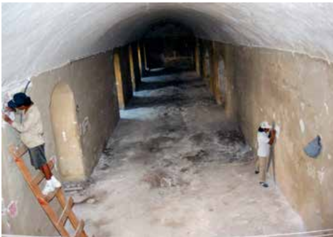
▲ Trabajo en muros. | © INAH, 1994.
