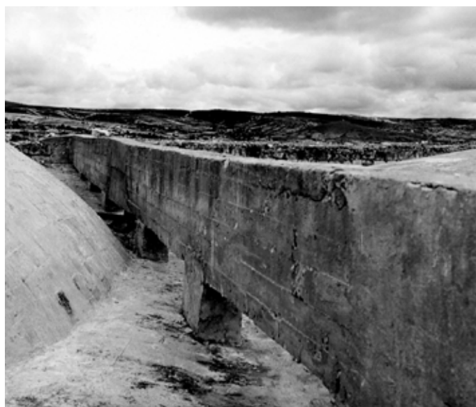
▲ Fig. 18 Zuncho de atado sobre las bóvedas. COIXTLAHUACA_11A-3_1964-1969. XXIII-11-2. F. Palancares. Fototeca CNCPC | © INAH, 1965.
