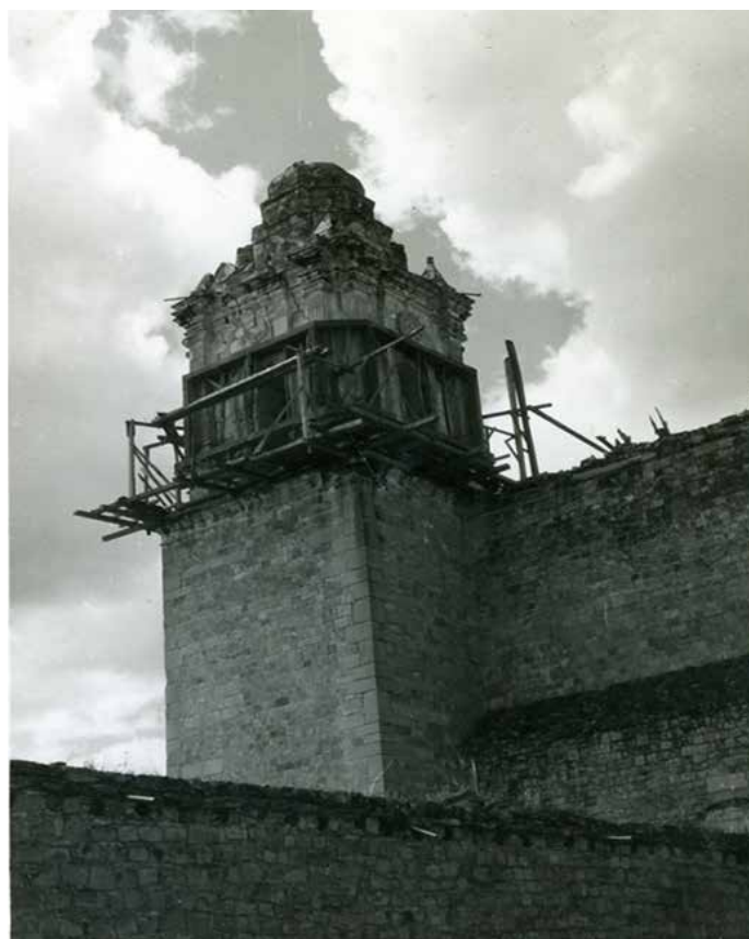
▲ Fig. 11 Estructura para montaje del zuncho. sn_folio122, V0A-15TVII-A, CNMH | © INAH.
