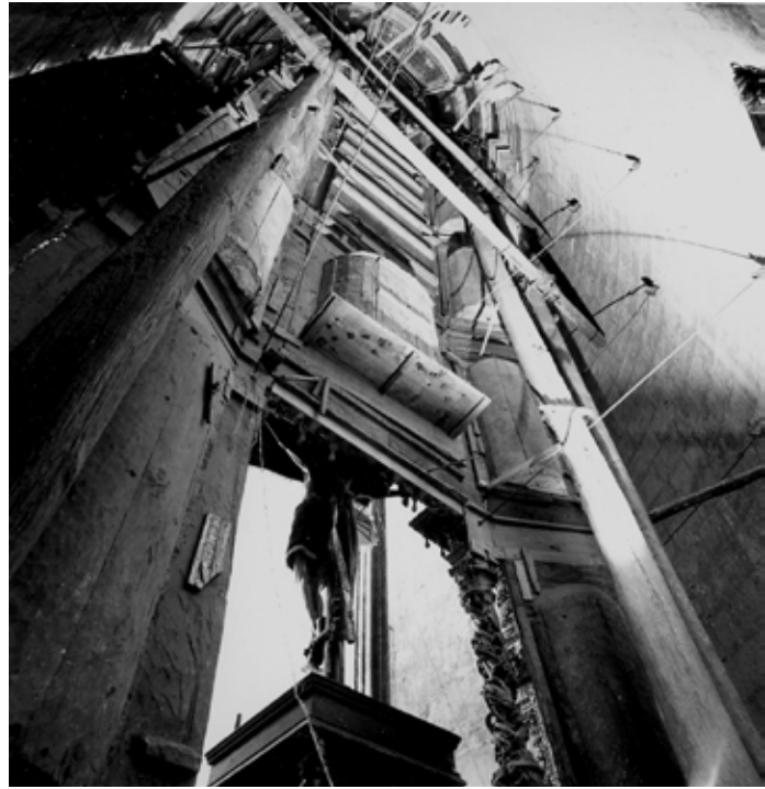
▲ Revisión de material de la fototeca de la CNRPC para reconocer el sistema constructivo del retablo antes de la colocación de la estructura metálica. Fuente: Fototeca CNCPC | © INAH, década de los 70/ ca. 1970
