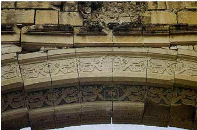
▲ Fig. 15 Dovelas centrales del arco de la capilla abierta antes de la restauración, 1954. | © VENCES, 2000: 252.
