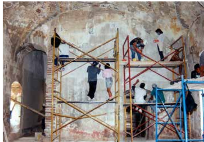
▲ Restauración de aplanados. | © INAH, 1994.
