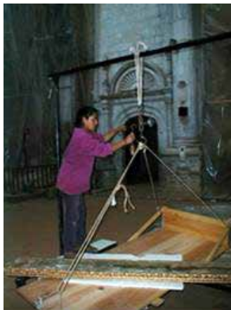
▼ Se pesaron cada uno de los elementos del tercer nivel. | © INAH, 2000.
