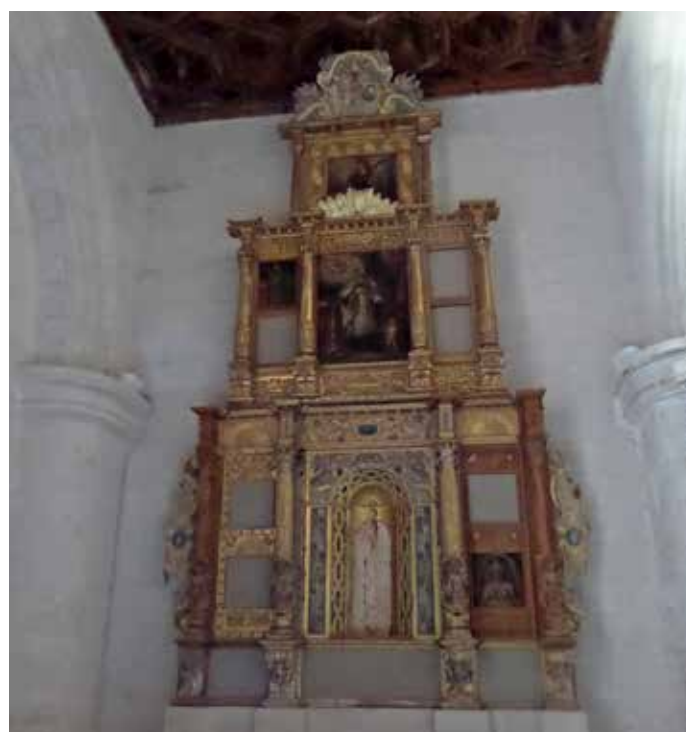
▲ No se tuvo el cuidado al cambiar de lugar los retablos y hacer nuevos altares de las dimensiones, forzando el remate de este retablo a ser colocado proyectado al frente para librar el artesón. | © INAH, 2014.
