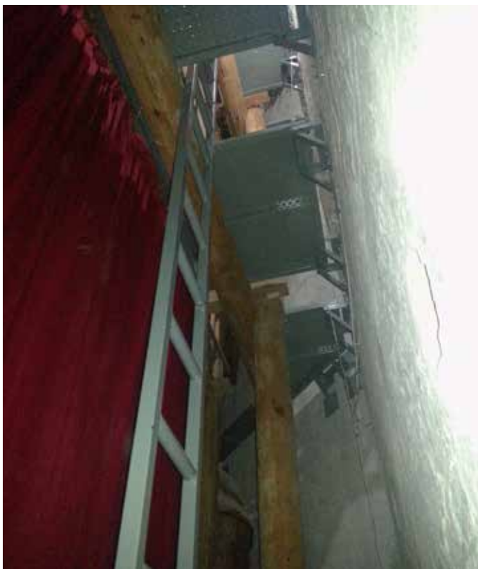
▲ Fig. 40 Estructura auxiliar añadida en la restauración tras el retablo de Coixtlahuaca. Fototeca CNCPC | © INAH, 2014.
