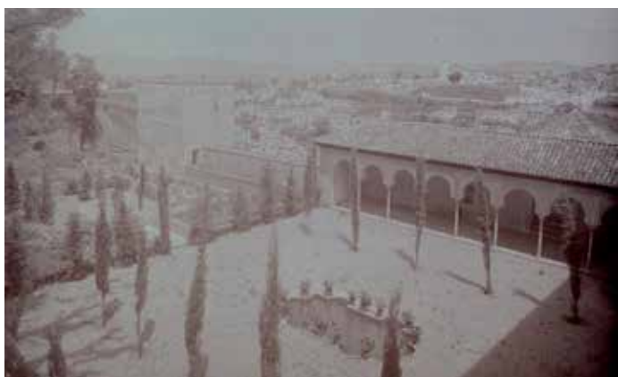
▲ Fig. 45 Aspecto que presenta esta zona - Patio de Machuca, su galería de arcos, y Madraza de los Príncipes - tras las obras de restauración de Torres Balbás, la vegetación ha sido cambiada y "reducida" dejando apreciar más el aspecto de conjunto de este espacio. | © APAG/ Colección de Fotografías/ F-00210, 1926 ca.
