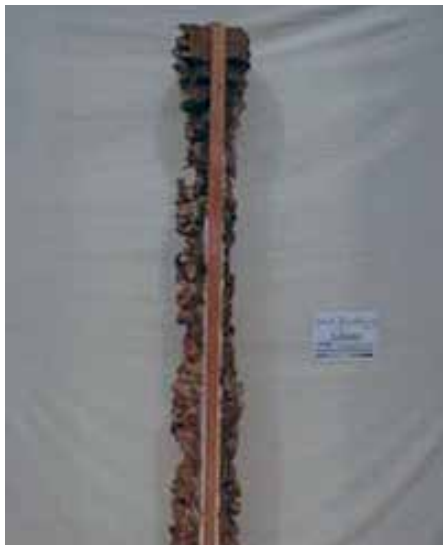
▲ Se eliminó la parte interna podrida de la columna para colocar un listón de cedro que reforzara como elemento de carga a la columna. | © INAH, 2000.
