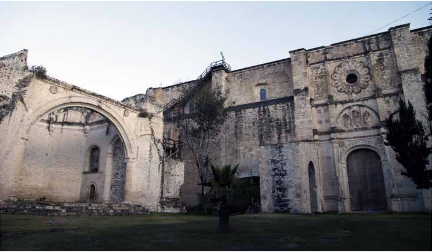
▲ Convento de San Juan Bautista de Coixtlahuaca, Oaxaca. | © INAH, 2012.
