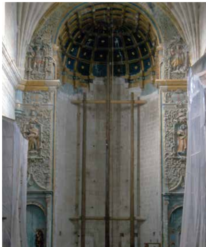
▲ Fig. 41 Estructura de soporte del retablo de Yanhuatlán. Fototeca CNCPC | © INAH, 2000.
