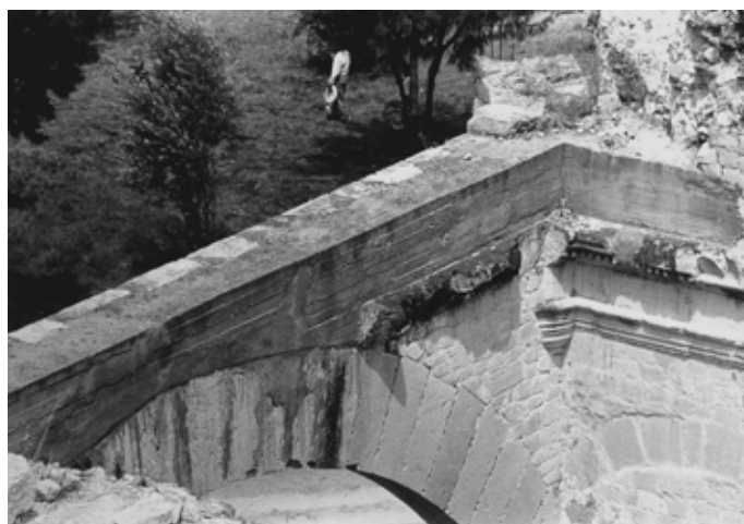
▲ Fig. 20 Zuncho de hormigón armado sobre el arco de la capilla abierta. COIXTLAHUACA_11A-1_1963-1969. XI-15-5-3. F. Palancares. Fototeca CNCPC | © INAH, 1964.
