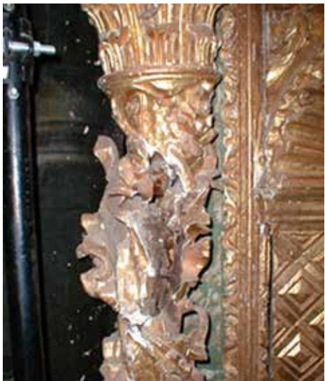
▲ Se eliminó la parte interna podrida de la columna para colocar un listón de cedro que reforzara como elemento de carga a la columna. | © INAH, 2000.
