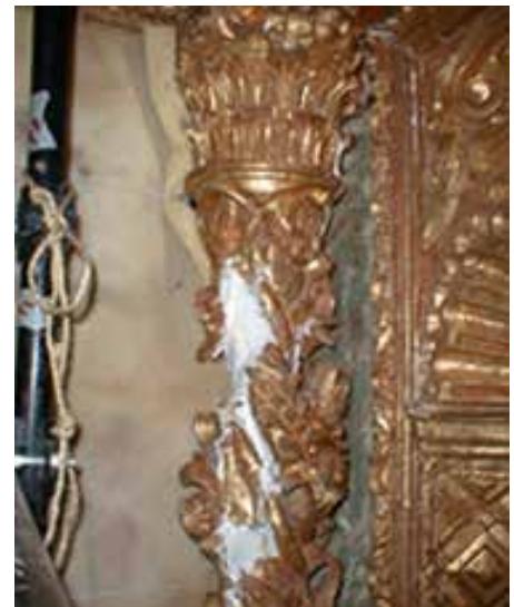
▲ Se eliminó la parte interna podrida de la columna para colocar un listón de cedro que reforzara como elemento de carga a la columna. | © INAH, 2000.
