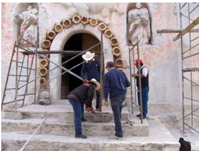
▲ Instalación de andamio para restauración de la fachada de Santa María Acapulco, San Luis Potosí | © INAH, 2007
