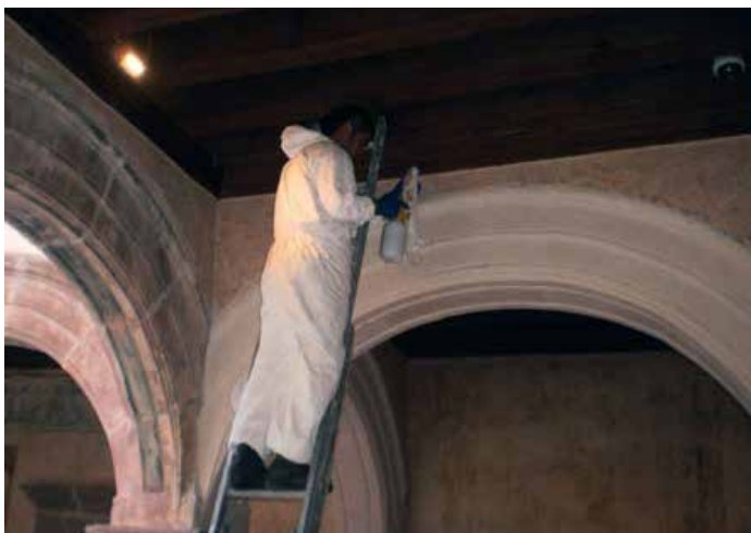
▲ Colocación de algodón con esencia de aceite de cedro en los albergues de los murciélagos localizados en la viguería | © CNCPC-INAH, 2013
