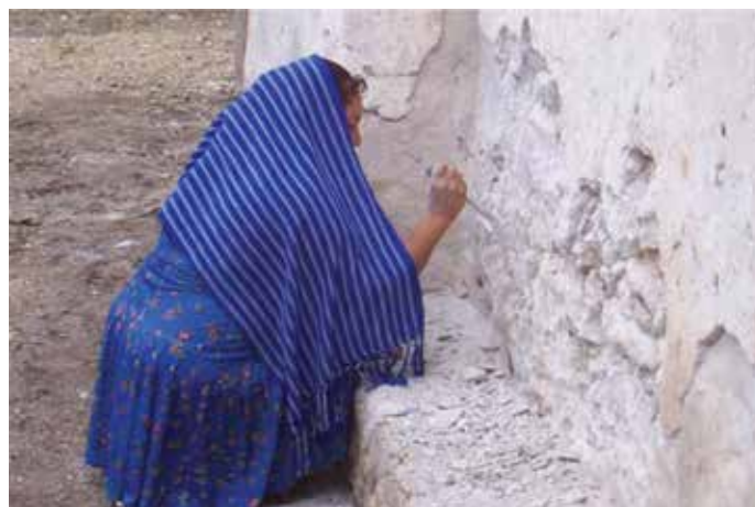
▲ Trabajos de conservación en fachada | © CNCPC-INAH, 2007
