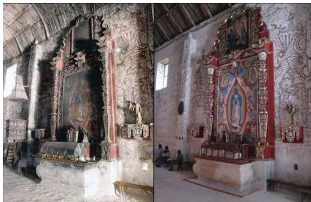
Altar de la Virgen de Guadalupe antes del incendio y después de la intervención | © CNCPC-INAH, 2006 y 2009
