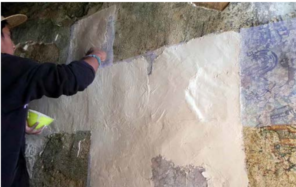
Figura 14. Proceso de colocación del primer aplanado del recubrimiento. Imagen: Gabriel Severiano, 2016, ©CNCPC-INAH.
