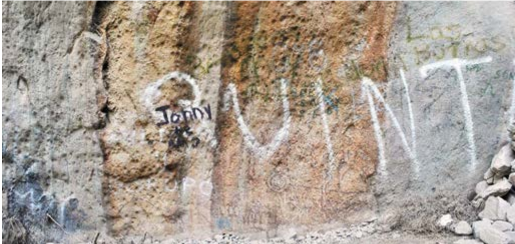
Figura 2. Graffiti dañando la pared con pinturas rupestres. Sitio La Ciénega, Nuevo León. Imagen: Omar Torres Cuervo, 2016, ©CNCPC-INAH.
