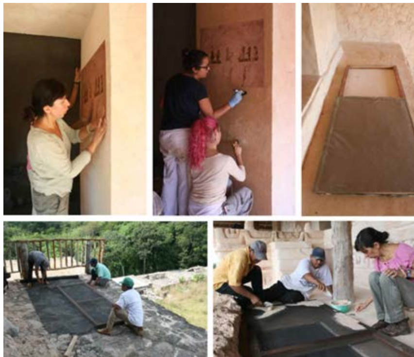
Figura 2. Sistema de re-enterramiento combinado con réplica en pintura mural expuesta y que requiere protección de radiación UV. Cuarto 42, Acrópolis. Imágenes: Alejandra Alonso. Proyecto de conservación de elementos decorativos y de recubrimiento de la zona arqueológica de Ek Balam, ©CNCPC-INAH.
