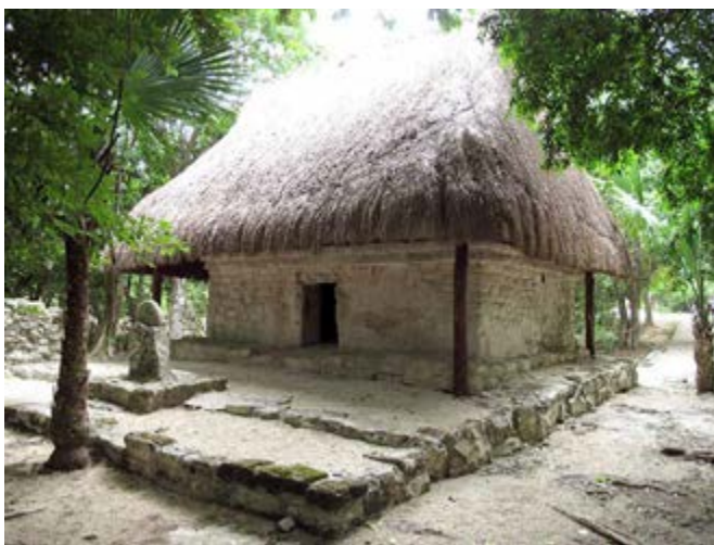
Figura 12. Estructura El Kisim, Calica, fachada noreste, fin de proceso. Imagen: Mónica A. López Portillo Guzmán, 2016, ©CNCPC-INAH.
