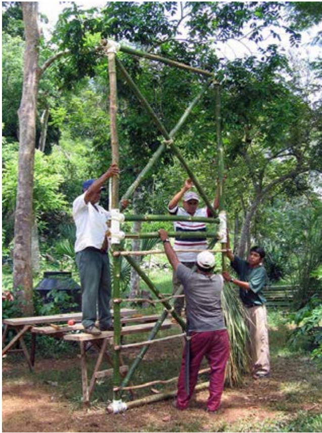
Figura 6. Trabajadores locales apoyando en la construcción de protecciones contra huracanes usando saberes tradicionales. Imagen: Proyecto de conservación 2013, ©CNCPC-INAH.
