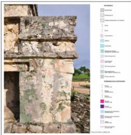
Figura 3. Ejemplo de un registro de deterioro. Microorganismos (algas, líquenes, bacterias, etc.) Registro: Claudia Trejo Murguía. Imagen: Víctor Gabriel Severiano Flores, ©CNCPC-INAH, 2013.
