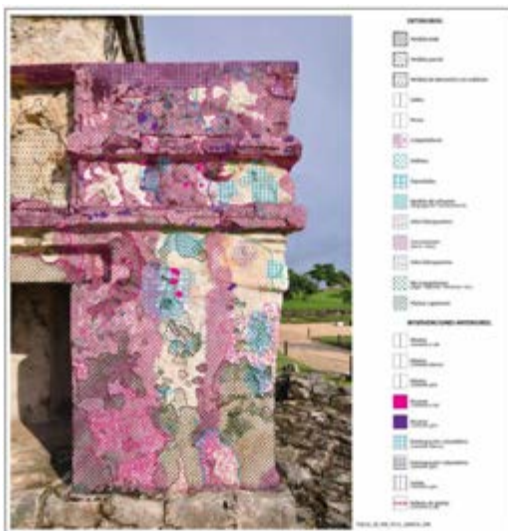
Figura 5. Ejemplo de un registro final. Estado de conservación - Deterioro e Intervenciones anteriores. Registro: Claudia Trejo Murguía. Imagen: Víctor Gabriel Severiano Flores, ©CNCPC-INAH, 2013
