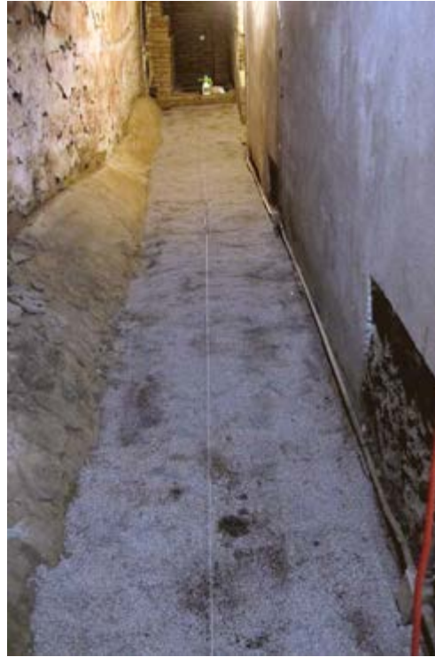
Figura 10. Nivelación del piso del túnel 6 para continuar con los trabajos de re-enterramiento. El uso de gravilla se utiliza como una marca para diferenciar el relleno arqueológico del relleno agregado para nivelar. Temporada 2016. Imagen: Archivo del Proyecto, ©CNCPC-INAH.
