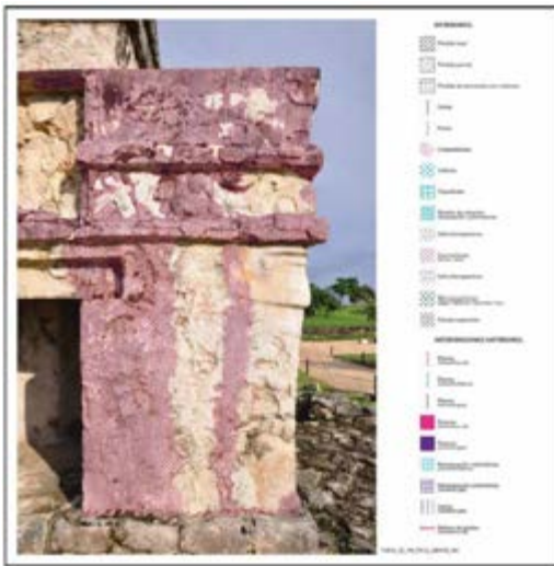
Figura 2. Ejemplo de un registro de deterioro. Concreciones (tierra, sales). Registro: Claudia Trejo Murguía. Imagen: Víctor Gabriel Severiano Flores, ©CNCPC-INAH, 2013.
