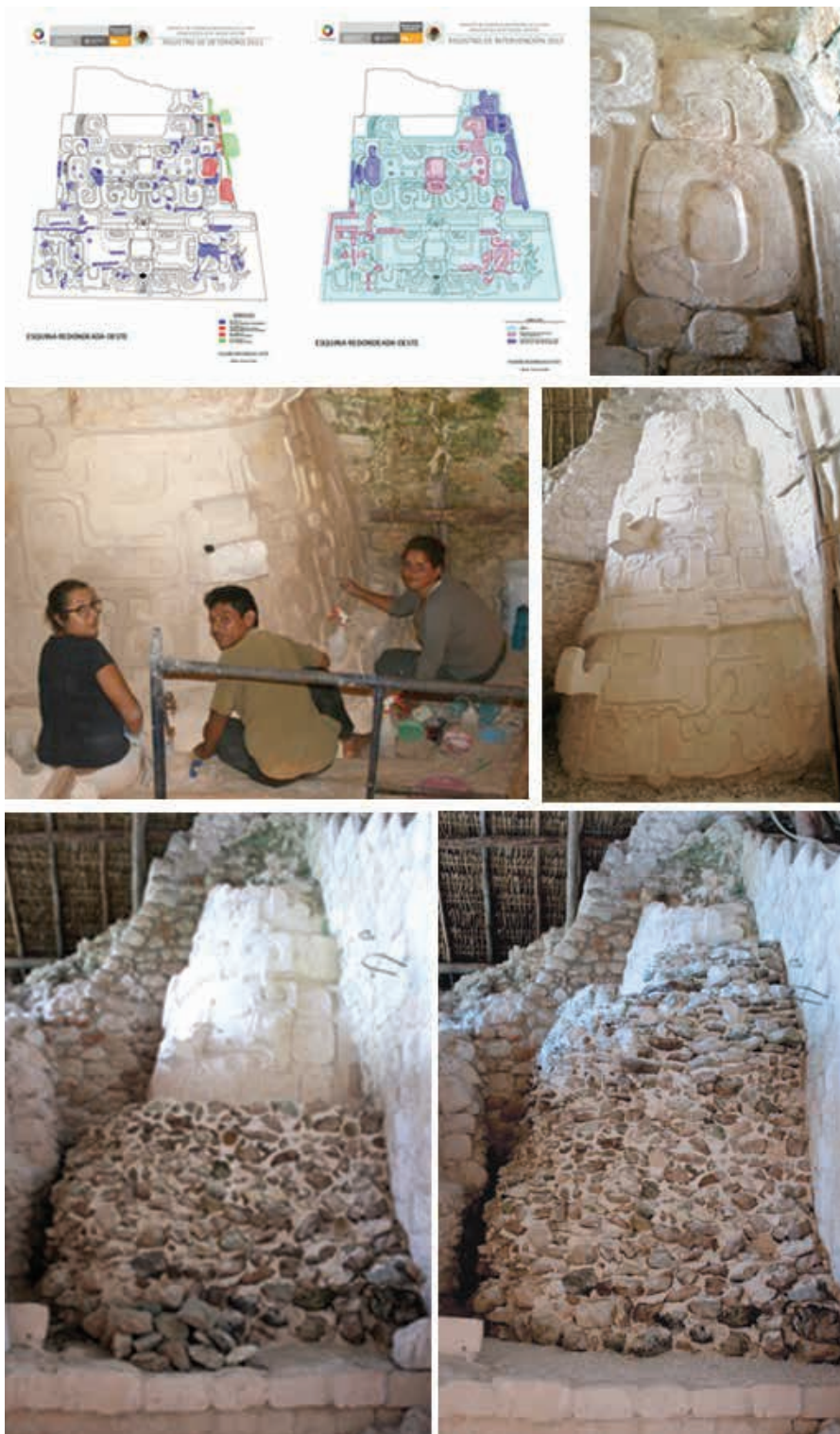
Figura 4. Sistema de re-enterramiento de elemento arquitectónico con relieves de estuco. Registro gráfico de daños y apariencia de la superficie que fue intervenida en la superficie de estuco disgregado, y aplicación del re-enterramiento. Esquina redondeada oeste, Acrópolis. Imágenes: Alejandra Alonso. Proyecto de conservación de elementos decorativos y de recubrimiento de la zona arqueológica de Ek Balam, ©CNCPC-INAH.
