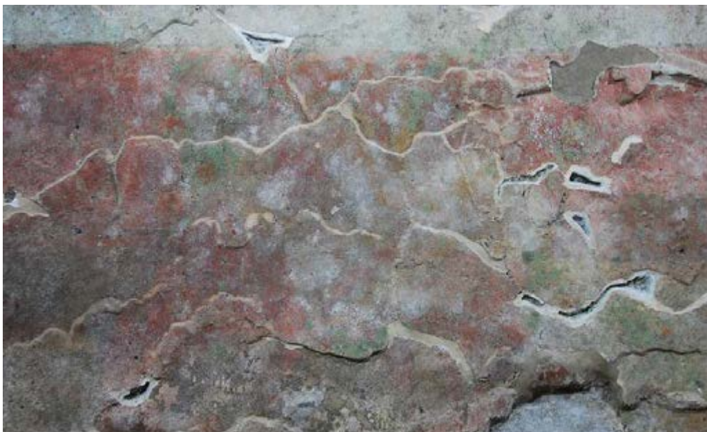
Figura 4. Detalle del mural donde se aprecian cúmulos verdes, blancos y amarillos que corresponden a actividad biológica mientras que las zonas grisáceas corresponden a eflorescencia de sales. La parte baja muestra afectación de la capa pictórica por disgregación. Imagen: ©CNCPC-INAH, 2013.
