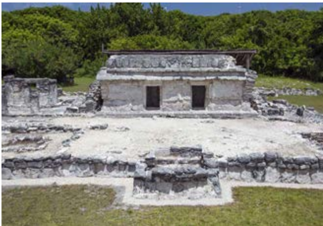
Figura 14. Estructura 3b, fachada poniente, fin de proceso. Imagen: Proa Producciones, 2016, ©CNCPC-INAH
