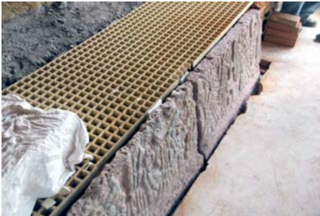
Figura 13. Proceso de montaje de los elementos de la banqueta. Imagen: Mariana Díaz de León Lastras, 2016, ©CNCPC-INAH.
