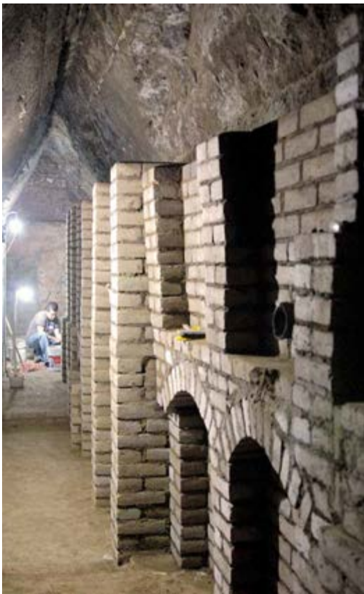
Figura 7. Vista del muro de re-enterramiento para el mural Los Bebedores aplicado durante la temporada 2016. Imagen: Archivo del Proyecto, ©CNCPC-INAH.
