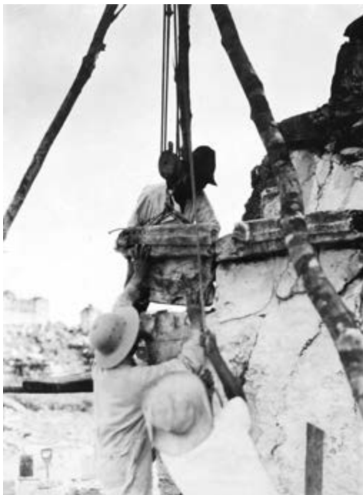
Figura 3. Proceso de reconstrucción del mascarón modelado en estuco de la esquina noroeste de la fachada principal del Edificio 16, Tulum. Imagen: Erosa, 1920.
