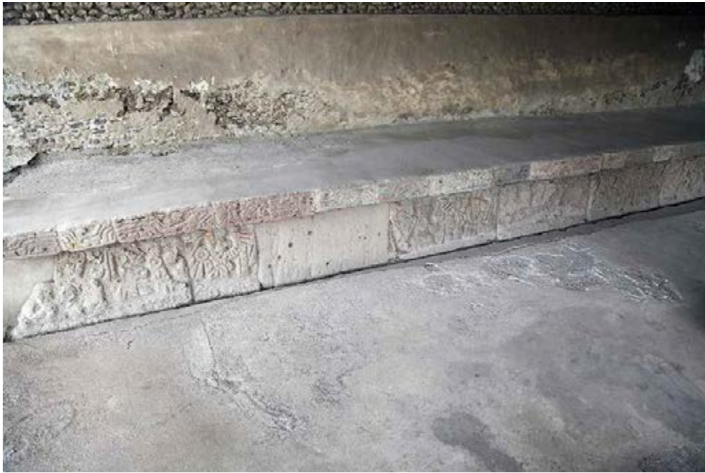
Figura 5. Lado norte de la banqueta de los caciques, antes de su intervención. Imagen: Julio Martínez Bronimann, 2014, ©CNCPC-INAH.
