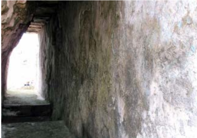
Figura 3. Imagen del interior del pasillo abovedado. Imagen: Gabriel Severiano, 2016, ©CNCPC-INAH.
