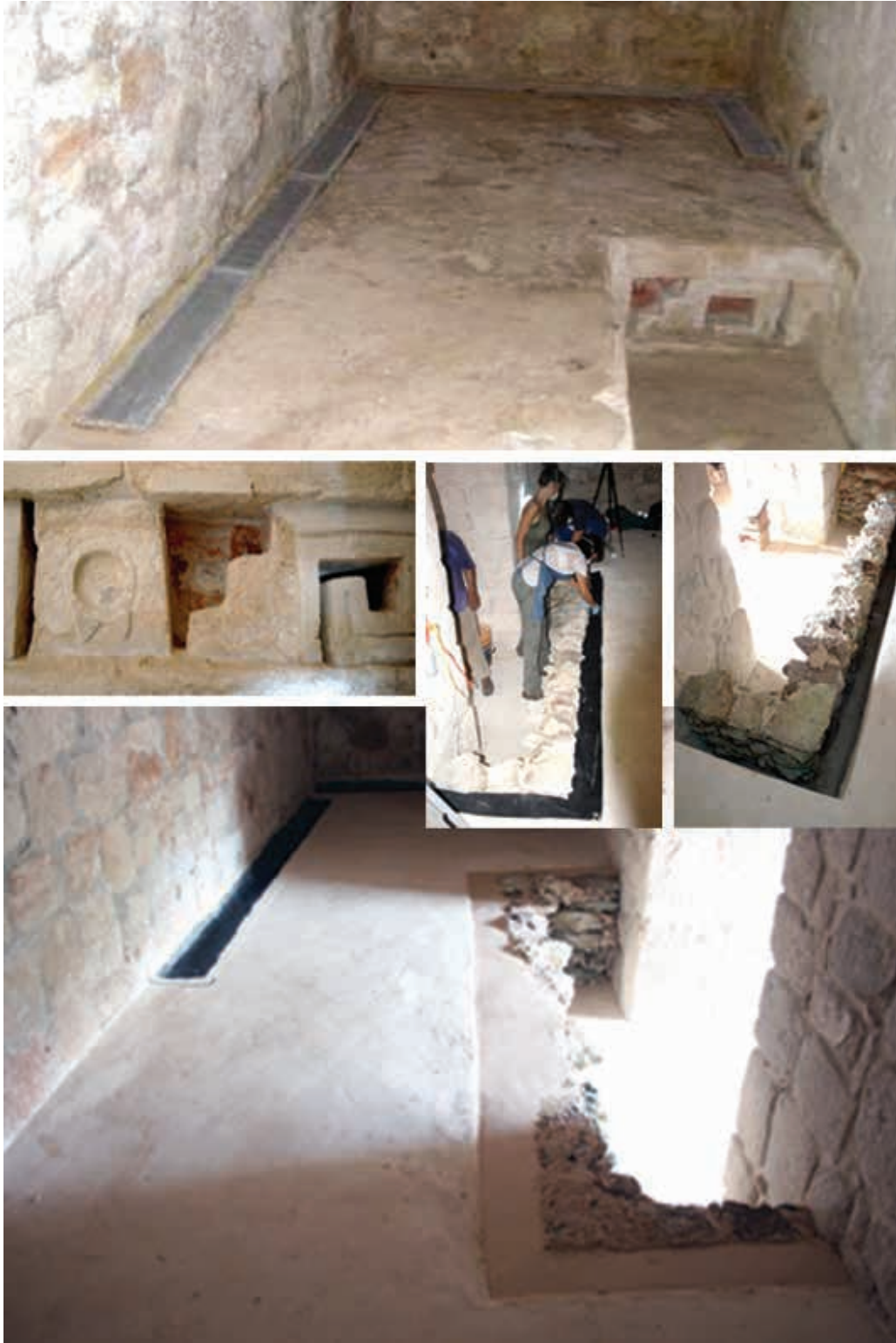
Figura 5. Re-enterramiento de la banca con relieves de estuco al cuarto 41 dentro del cuarto 44, en la Acrópolis. Este elemento se re-enterró en el 2016. Imágenes: Alejandra Alonso. Proyecto de conservación de elementos decorativos y de recubrimiento de la zona arqueológica de Ek Balam, ©CNCPC-INAH.
