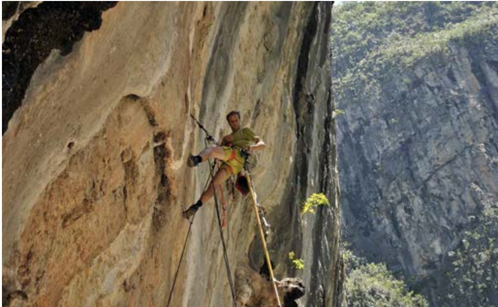
Figura 5. Remoción de elementos metálicos que afectaban la pared con pinturas rupestres. Sitio La Ciénega, Nuevo León. Imagen: Omar Torres Cuervo, 2016, ©CNCPC-INAH.
