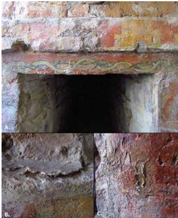
Figura 9. Tumba 125, Monte Albán. A. Foto general de la pintura mural de la entrada de la tumba. B. Detalle de desprendimiento de aplanados y capa pictórica. C. Detalle de exfoliación de capa pictórica por presencia de polímeros. Imágenes: Mónica Vargas Ramos, 2015, ©CNCPC-INAH.
