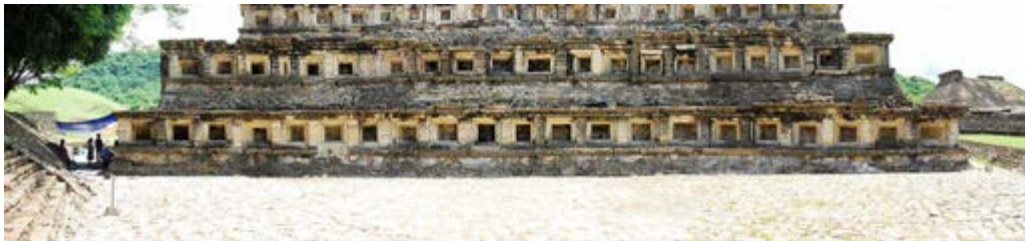
Figura 4. Fotografía completa de los cuerpos 1 y 2, fachada Oeste. Elaboró: Jesús Alfonso Osorio Martínez. Imagen: ©CNCPC-INAH, 2014.
