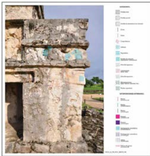
Figura 4. Ejemplo de un registro de intervenciones. Reintegración volumétrica (cemento blanco). Registro: Claudia Trejo Murguía. Imagen: Víctor Gabriel Severiano Flores, ©CNCPC-INAH, 2013.
