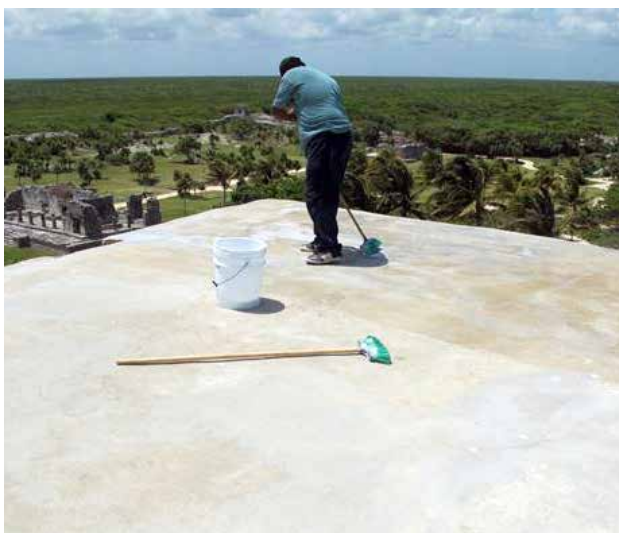
Figura 6. Impermeabilización de techos con alumbre y jabón. Imagen: Fernando Godos, 2014, ©CNCPC-INAH.
