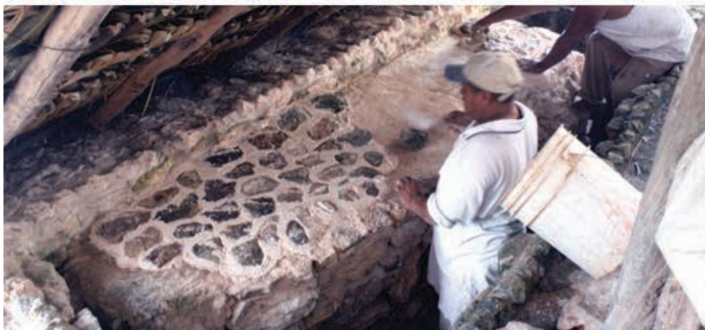
Figura 6. Re-enterramiento de un elemento decorativo de una fachada de una subestructura del cuarto 44. Imágenes: Alejandra Alonso. Proyecto de conservación de elementos decorativos y de recubrimiento de la zona arqueológica de Ek Balam, ©CNCPC-INAH.
