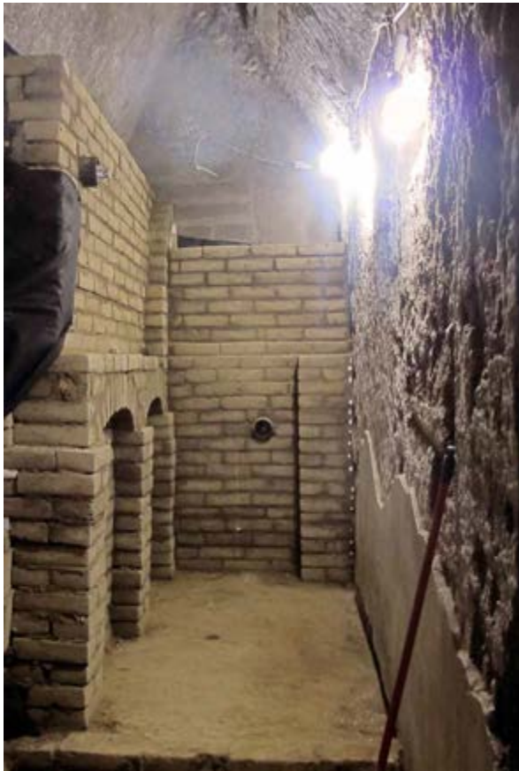
Figura 5. Vista del muro de protección temporal instalada en 2015, sobre sección norte del mural Los Bebedores y mural contiguo. Temporada 2015. Zona arqueológica de Cholula Puebla. Imagen: Archivo del Proyecto, ©CNCPC-INAH.
