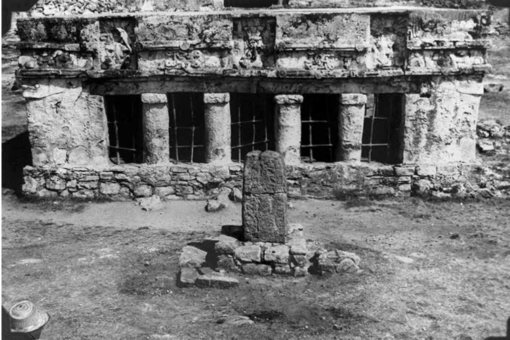
Figura 4. Fotografía tomada durante las exploraciones en Tulum en 1975. Fachada principal del Edificio 16. En los tres primeros dinteles (izquierda-derecha) ya se observan las grietas monitoreadas actualmente por el proyecto. Imagen: Velázquez, 1975.
