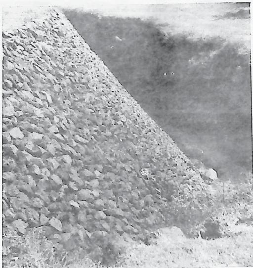
4. Sección sur del talud inferior, mostrando el estado actual de la gran excavación de Cummings en 1925. Al contrario de lo que tradicionalmente se repite, el muro es completamente original (menos el desagüe), y no fue reconstruido ni modificado.
