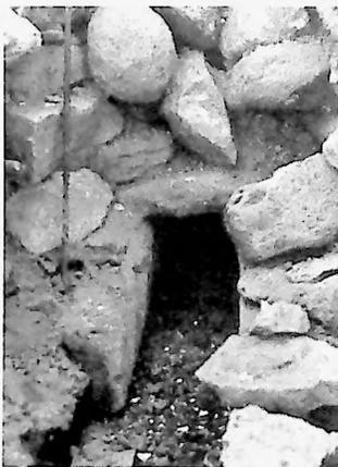
◀ Drenaje construido al edificarse la Plataforma. Se aprecia el sistema constructivo con la cantería. Una vez construido el drenaje se procedía con el sistema de rellenos por cimentación de retícula.
