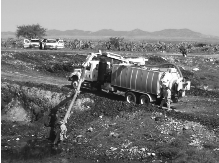
Foto 3. Uso del camión Hidroneumático Acuatech para desazolve
