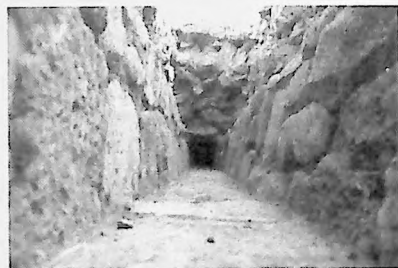
▲ Los lechos de las cañerías de los drenajes
