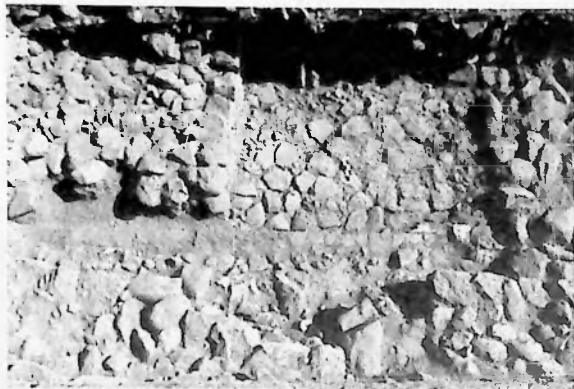
◀ Sistema de cimentación de retícula, construido con piedras
