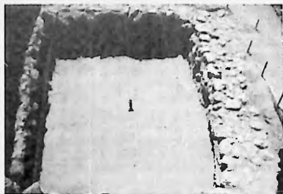
▲ Sistema de cimentación de piedras con el cual se concluyó la nivelación de la explanada antes de culminar con el enlucido de la Plazoleta Norte
