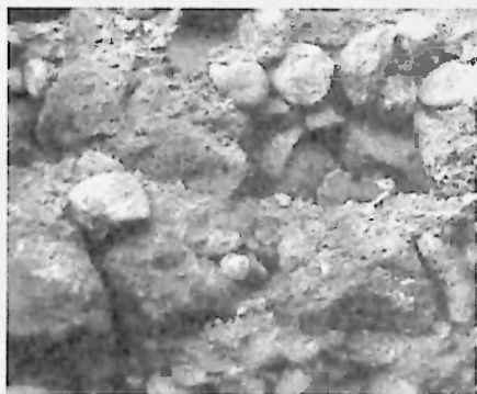
◀ Acercamiento del sistema terciado descubierto por Acosta. Obsérvese la secuencia repetitiva del acomodo del barro, la piedra chica para rellenar los intersticios y la piedra grande
