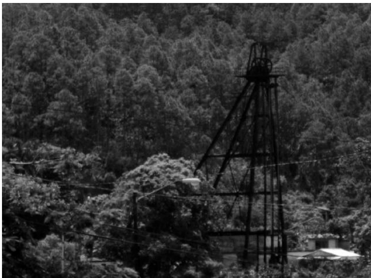
Figura 26 Vista actual del pozo #1
