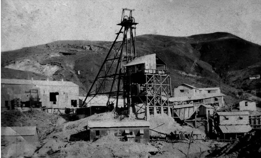
Figura 25 Vista del pozo # 1
