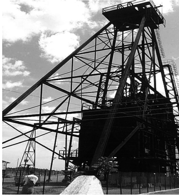
Figura 27 Vista actual del pozo #2
