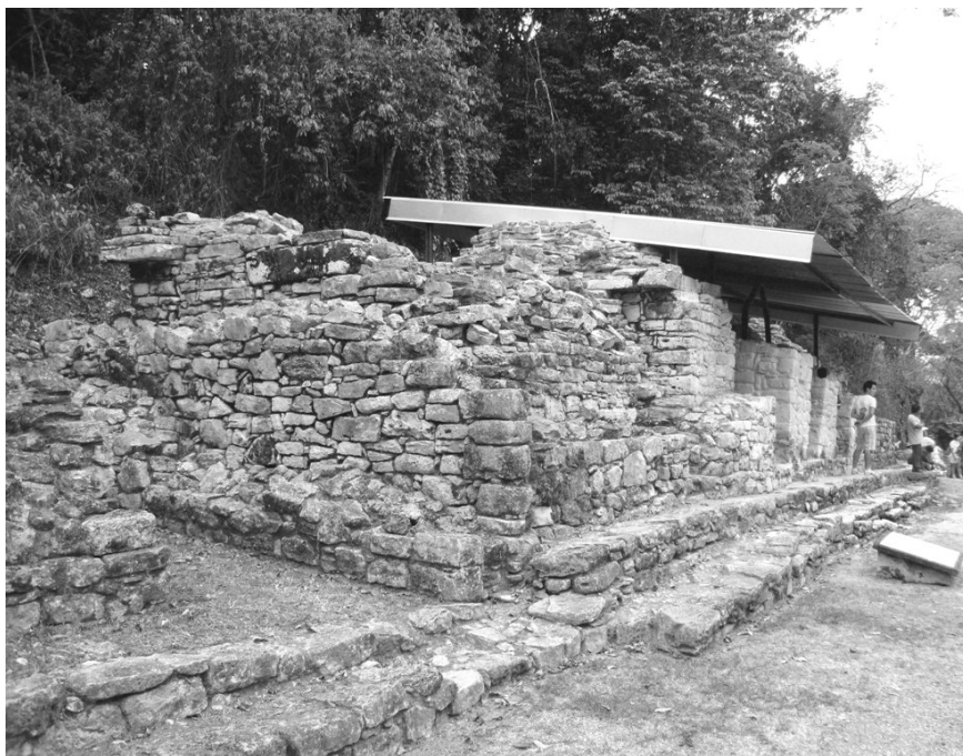
Foto 3 Panorámica del Edificio 21
