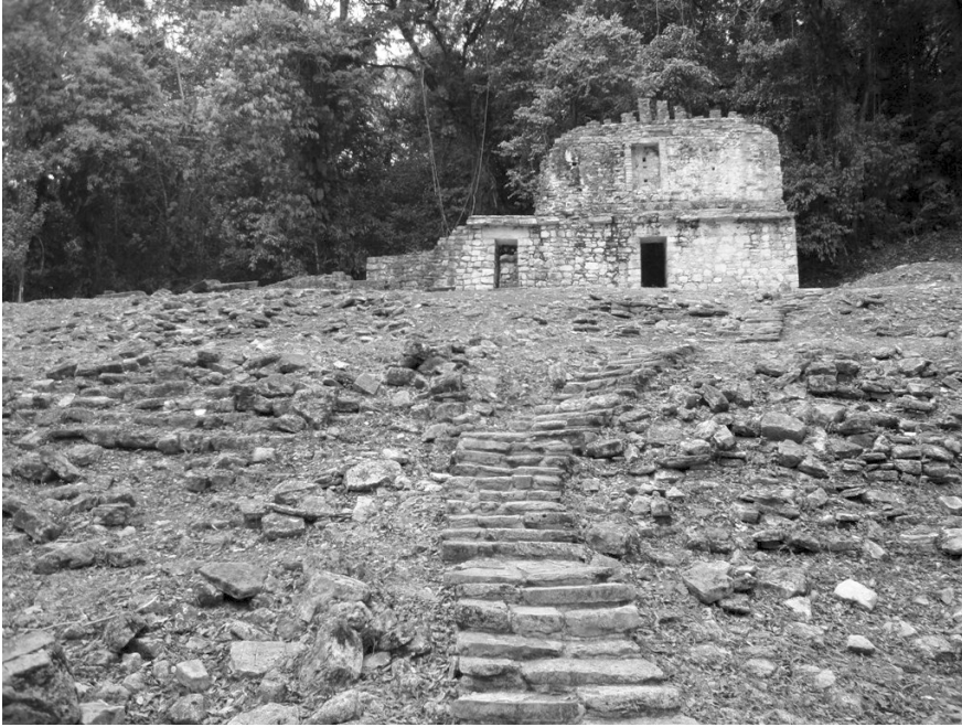
Foto 2 Fachada frontal del Edificio 20
