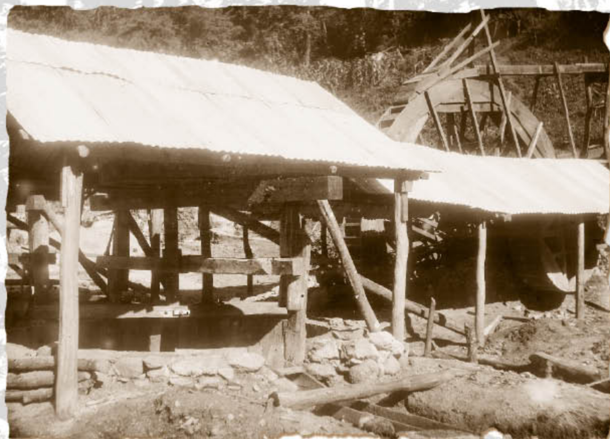
Foto 9: Cobertizo que cubre instalaciones de arrastre y vertiente de agua para lavar oro. Placeres del Oro. © Colección William Niven, cortesía Roland H. Harrison.
