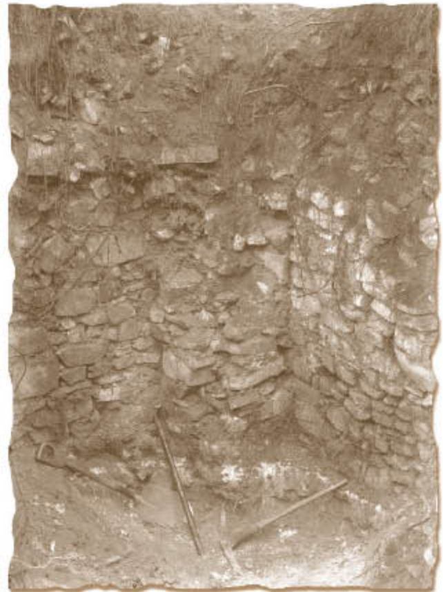
Esquina formada por una plataforma y la alfarda de una escalinata, llamada "altar" por Niven, en El Jabalín. Nótese las herramientas usadas para su excavación. © Wicks, S. Robert & Harrison H. Roland, Buried Cities, Forgotten Gods. William Niven's life of discovery and revolution in Mexico and the American Southwest , Texas Tech University Press, 1999.
