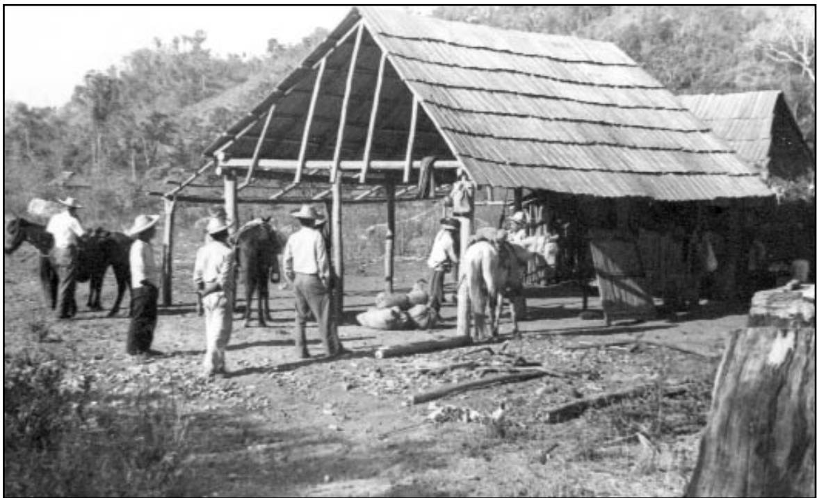
Construcción de una casa en Chilacachapa, ca. 1945.
