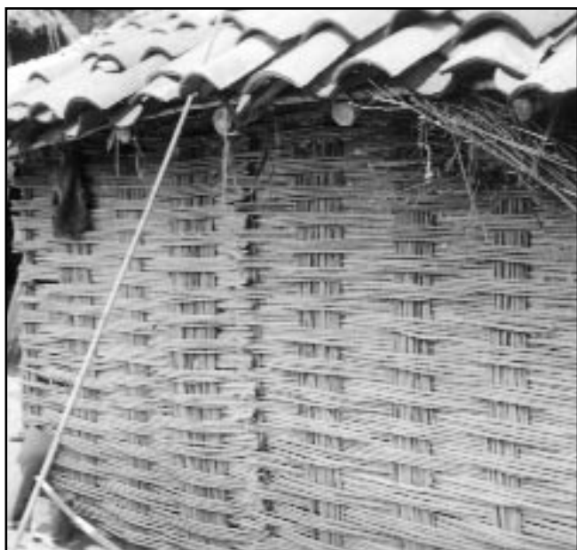
Casa humilde de varas entretrejidas. Ahuacatitlan.
