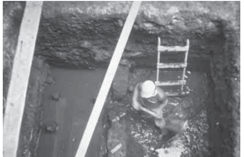
Excavación arqueológica y vigilancia de obra en monumento histórico, recimentación de Palacio Nacional, D. F. © Archivo Dirección de Salvamento Arqueológico-INAH.
