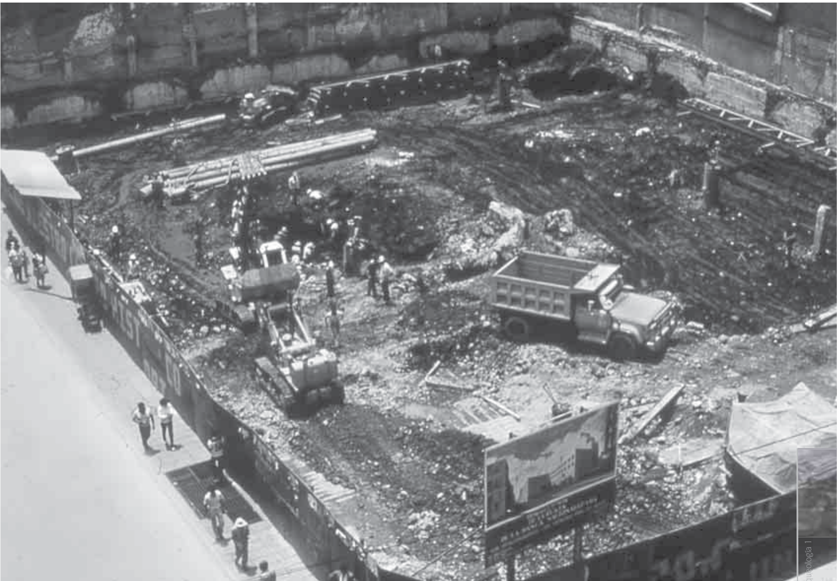
Excavación arqueológica, vigilancia de obra y construcción de Edificio Anexo Sede Banamex, D. F. © Archivo Dirección de Salvamento Arqueológico-INAH.
