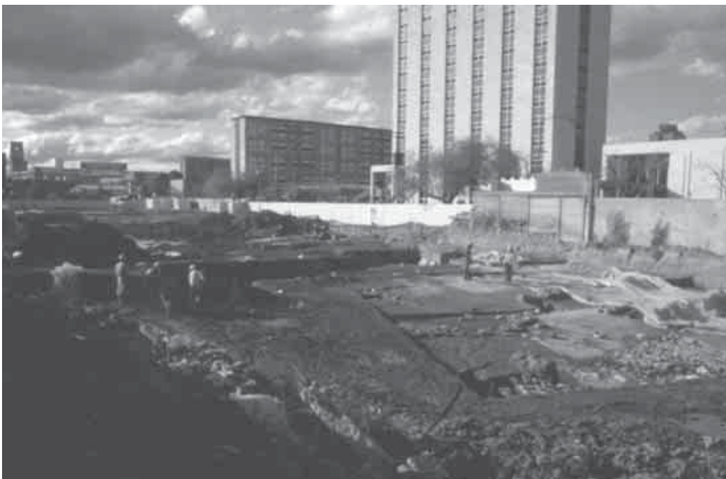
Proceso de excavación arqueológica, vigilancia de obra y construcción en el Edificio Anexo de la Secretaría de Relaciones Exteriores, D. F. © Archivo Dirección de Salvamento Arqueológico-INAH.
