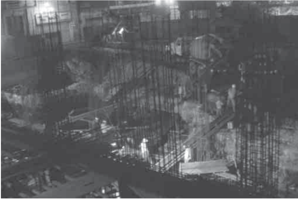
Proceso de excavación y vigilancia de obra nocturna en la construcción del edificio anexo Banamex, Capuchinas, D. F. © Archivo Dirección de Salvamento Arqueológico-INAH.
