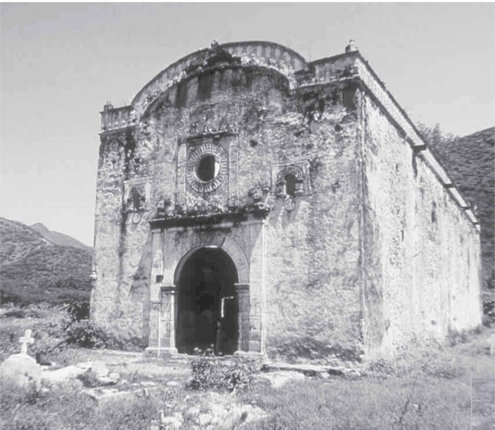
Registro de evidencias históricas. Capilla que fue cubierta por embalse de la presa hidroeléctrica Chicoasén, Chiapas. © Archivo Dirección de Salvamento Arqueológico-INAH.
