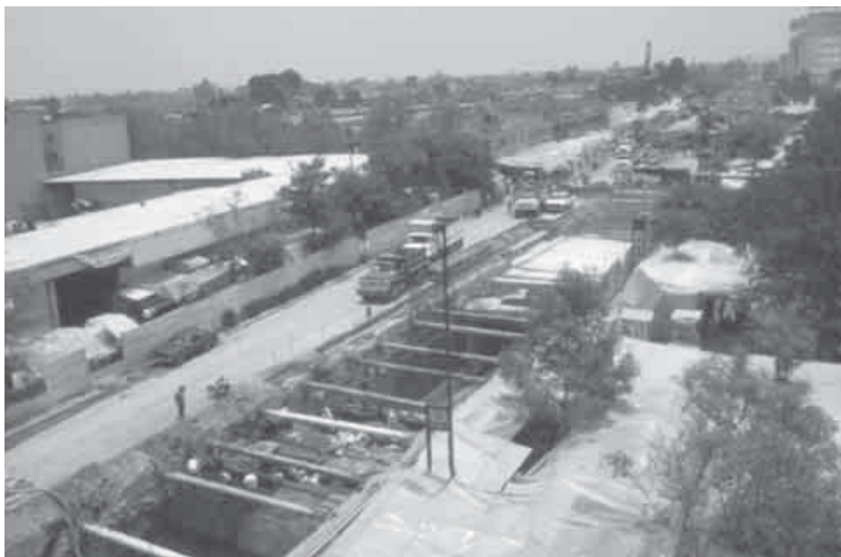
Vaciado de "cajón" en la construcción de la Línea B del Metro, D. F. © Archivo Dirección de Salvamento Arqueológico-INAH.
