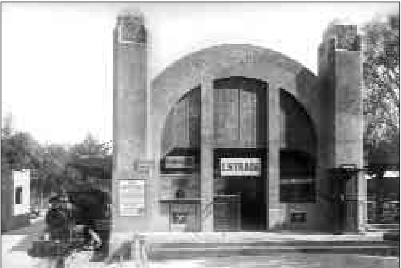
Compañía Industrial Fotográfica, fachada de la estación del Ferrocarril Escénico de Chapultepec. Arq. José Gómez Echeverría, 1928. En el cartel de la extrema izquierda podía leerse: Niño: Fíjate bien que esta estación es de una sola pieza. Aquí no hay juntas porque no fue construida piedra sobre piedra, sino moldeada en concreto. Esta estación durará muchos siglos porque el concreto se hace con cemento. Cuando seas grande tus palacios los harás de concreto. La Tolteca, Cía de Cementos Portland, S.A. Av. Independencia 8, ca. 1930. © Fototeca Nacional del INAH.
