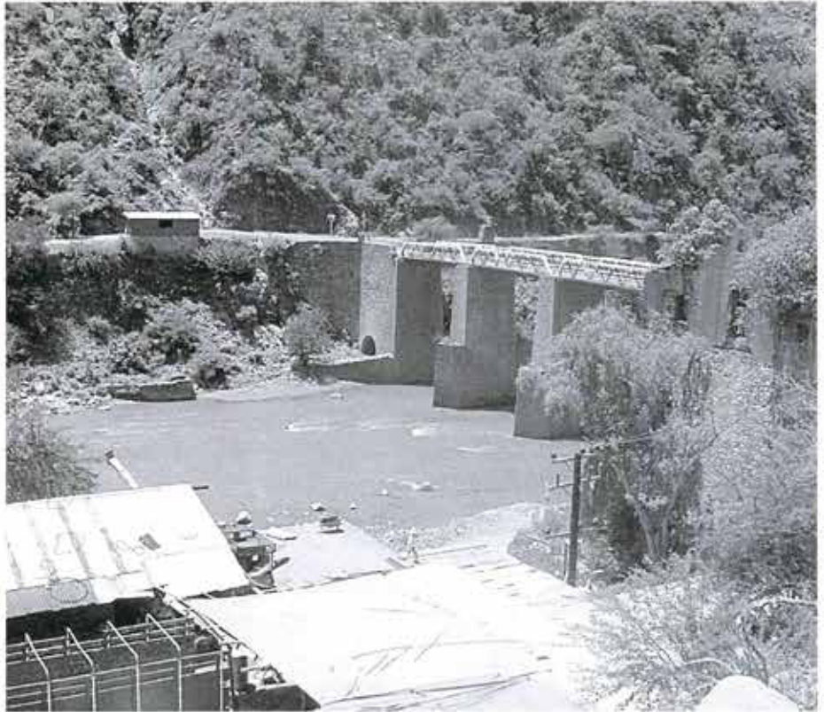
Figura 1. Puente Miguel Ahumada construido por la Batopilas Mining Co. a fines del siglo XIX para comunicar por ferrocarril sus minas sus yacimientos mineros en la zona.
