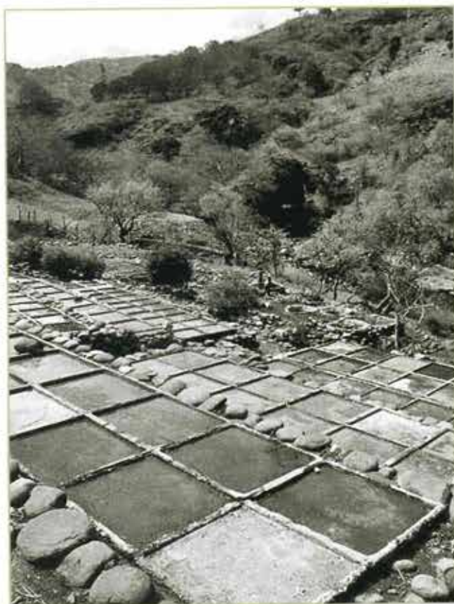
Victor Osorio. Sustitución los poches por "carreras" de cemento, Estado de México, 2007.
