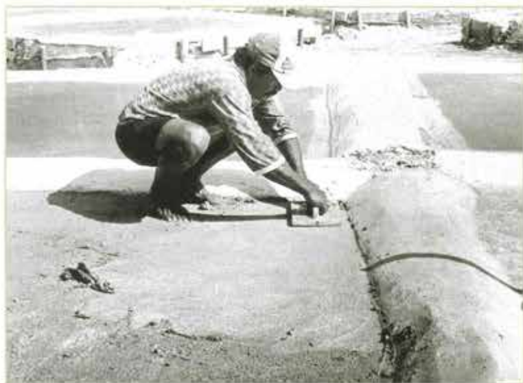
Figura 5. Eduardo Williams. Michoacán, Alisando la superficie de la "era" con el "menapil" para impermeabilizarla, La Placita, Costa de Michoacán, 2000.
