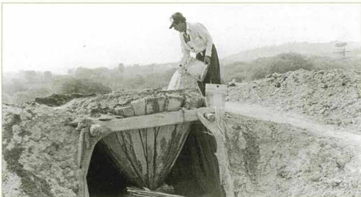
Figura 3. Eduardo Williams. Michoacán, Vertiendo el agua del manantial en la "estiladera" para el lixiviado de tierras , San Nicolás Simirao, Cuitzeo, Michoacán, 1998.
