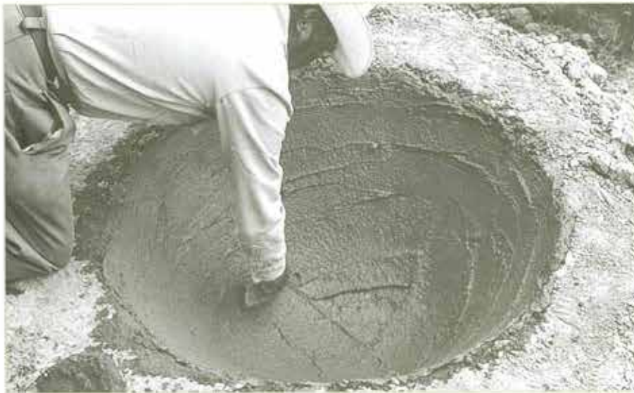
Figura 15. Jeffrey R. Parsons. Alisando las paredes de la pila con un suelo de yeso, taller de Sebastián Nopalitla, Nexquipayac, 1988.
