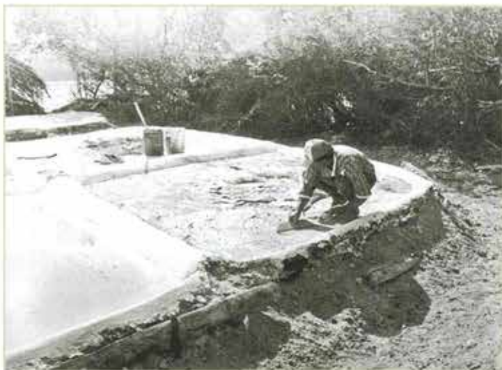
Figura 4. Eduardo Williams. Michoacán, Preparando la "era" con una mezcla de cal, utilizando la "palera", La Placita, Costa de Michoacán, 2000.
