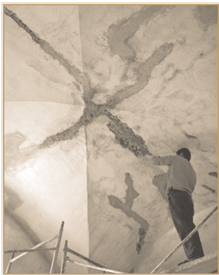
Norma Laguna Orduña. Preparación de superficie para la aplicación de acabado, Santa Prisca y San Sebastián, Taxco de Alarcón, Guerrero.
