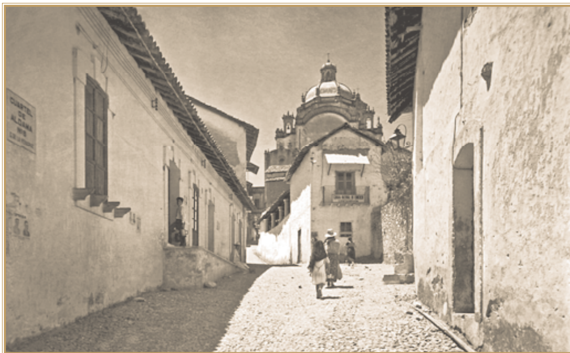
Cía. Fot. Méx. 7 N. Vista desde la calle de la Veracruz, Taxco de Alarcón, ca. 1950. Colección Blanca Jiménez-Samuel Villela.
