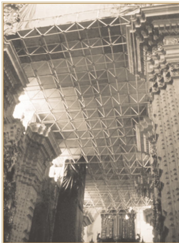
Norma Laguna Orduña. Montaje de tapanco para trabajos de la nave principal, Santa Prisca y San Sebastián, Taxco de Alarcón, Guerrero.
