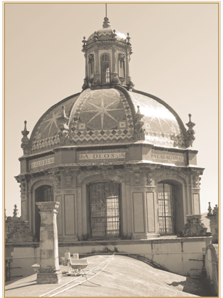
Norma Laguna Orduña. Vista de la cúpula terminada, Santa Prisca y San Sebastián, Taxco de Alarcón, Guerrero.
