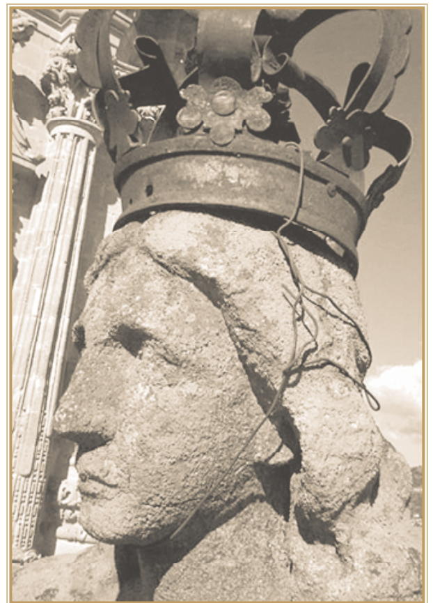
Norma Laguna Orduña. Condición de las superficies de cantera por pérdida de veladura de protección, Santa Prisca y San Sebastián, Taxco de Alarcón, Guerrero.
