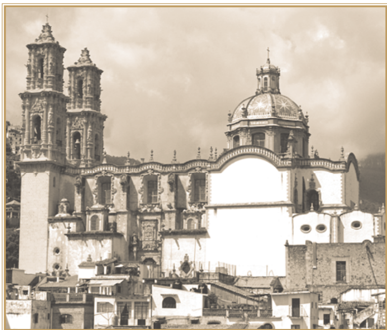
Issac Estrada. Intervención terminada en la torre sur, sacristía, cúpula y cruz de la nave principal, Santa Prisca y San Sebastián, Taxco de Alarcón, Guerrero.
