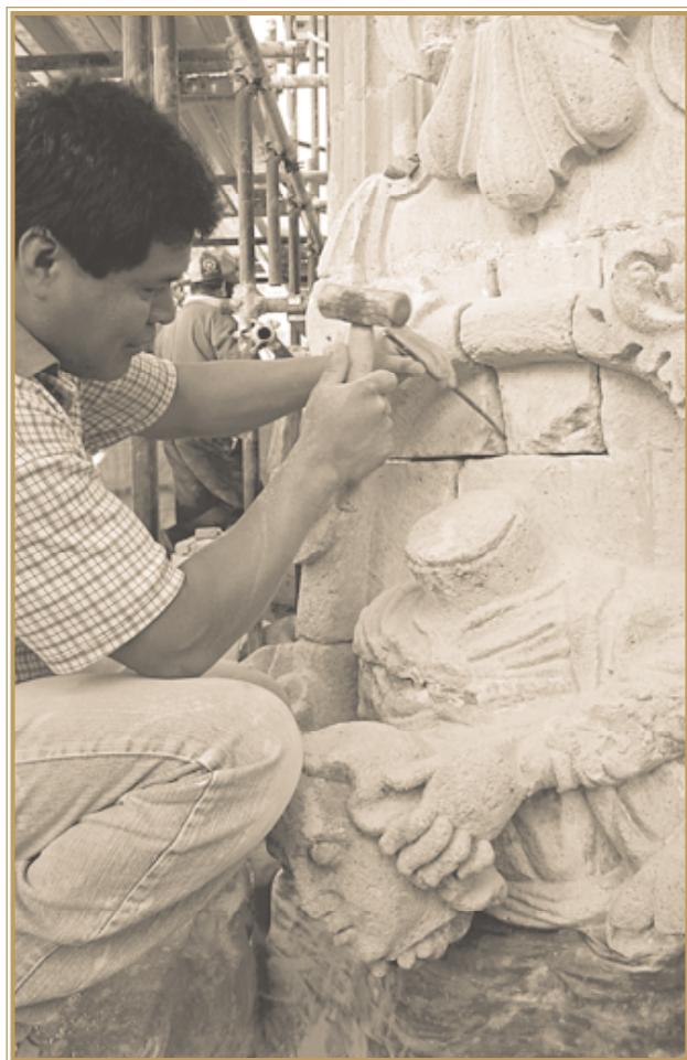
Issac Estrada. Retiro de juntas flojas en estructura de cantera, Santa Prisca y San Sebastián, Taxco de Alarcón, Guerrero.
