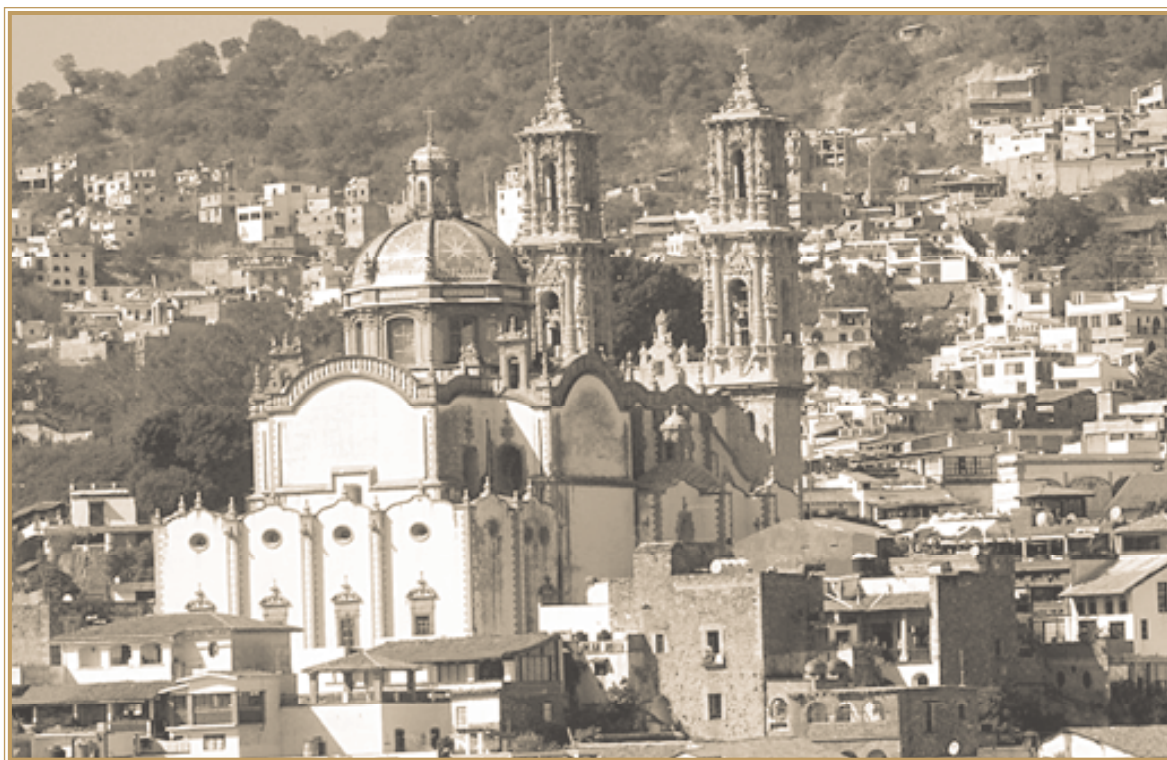
Issac Estrada. Intervención terminada, vista de la fachada noreste de la cúpula de la nave principal y sacristía, Santa Prisca y San Sebastián, Taxco de Alarcón, Guerrero.
