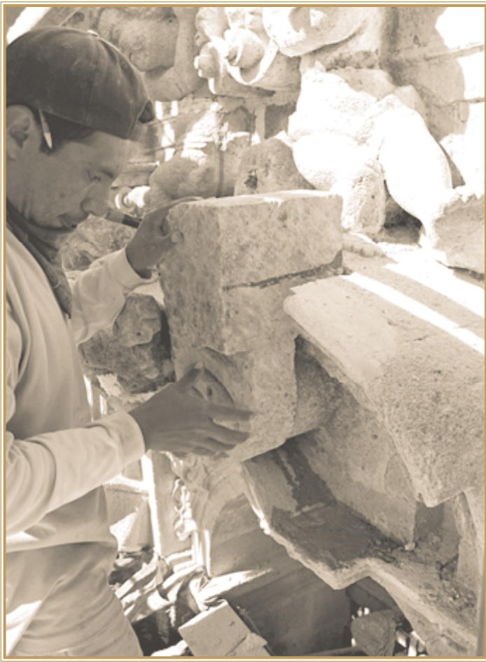
Issac Estrada. Restitución de sillares de cantera fracturadas y/o en proceso de expoliación, Santa Prisca y San Sebastián, Taxco de Alarcón, Guerrero.
