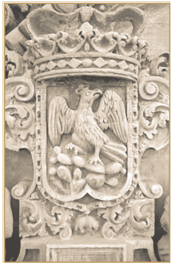
Issac Estrada. Imagen del mismo escudo al término de los trabajos, Santa Prisca y San Sebastián, Taxco de Alarcón, Guerrero.
