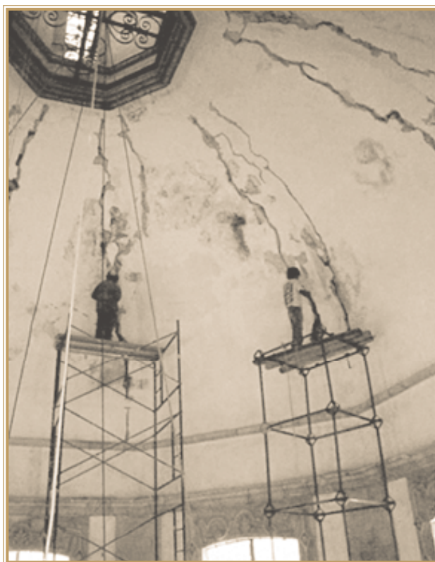
Norma Laguna Orduña. Consolidación de la estructura de la cúpula, Santa Prisca y San Sebastián, Taxco de Alarcón, Guerrero.
