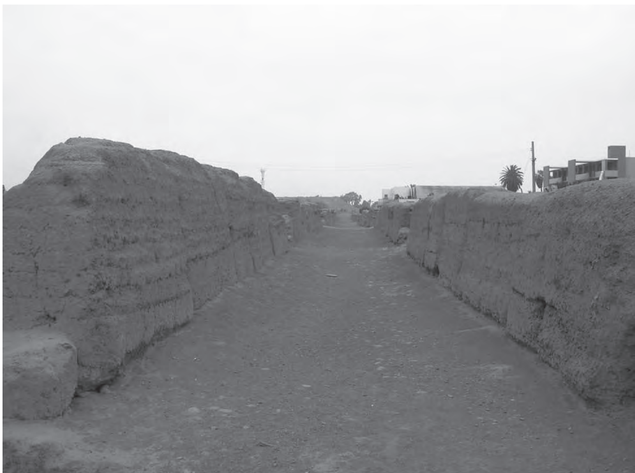
Figura 3 El camino con muros laterales de tapial dentro del campus de la Pontificia Universidad Católica del Perú, Lima. El camino se dirige hacia Huaca Tres Palos en el parque de Las Leyendas Fotografía F. Ugaz
