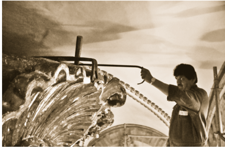
Alejandra Bourillón. Detalle de la devolución del plano por medio de tensores metálicos, Santa Prisca y San Sebastián, Taxco de Alarcón, Guerrero.
