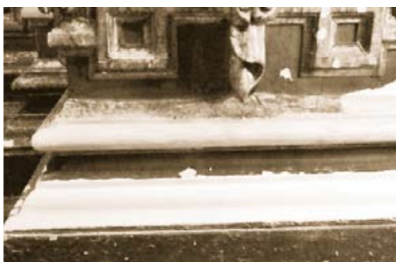
Alejandra Bourillón. Detalle de reintegración de dorados, aplicación de bol, aplicación de oro y aplicación de micas, Santa Prisca y San Sebastián, Taxco de Alarcón, Guerrero.
