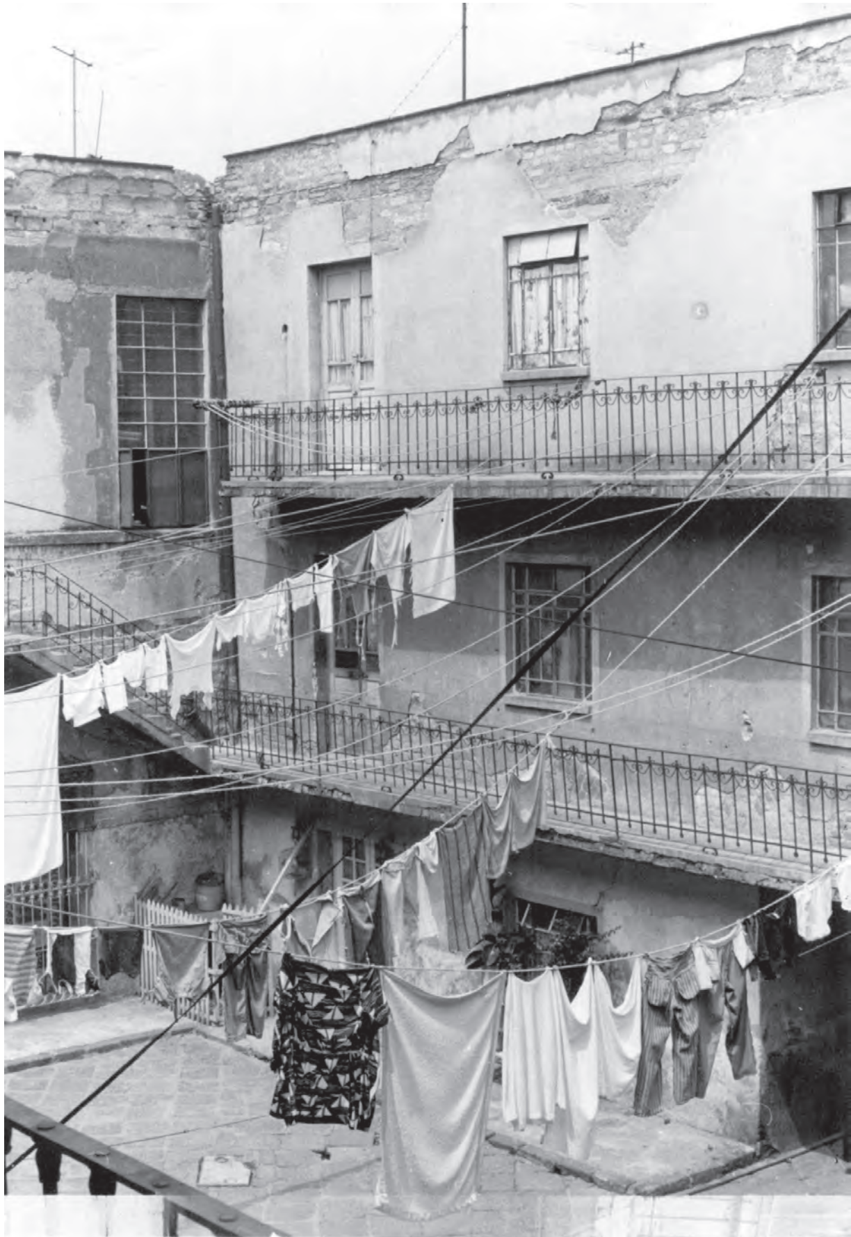
Interior, calle Jesús Carranza núm. 24 Fotografía JARLO, 1970-1974
