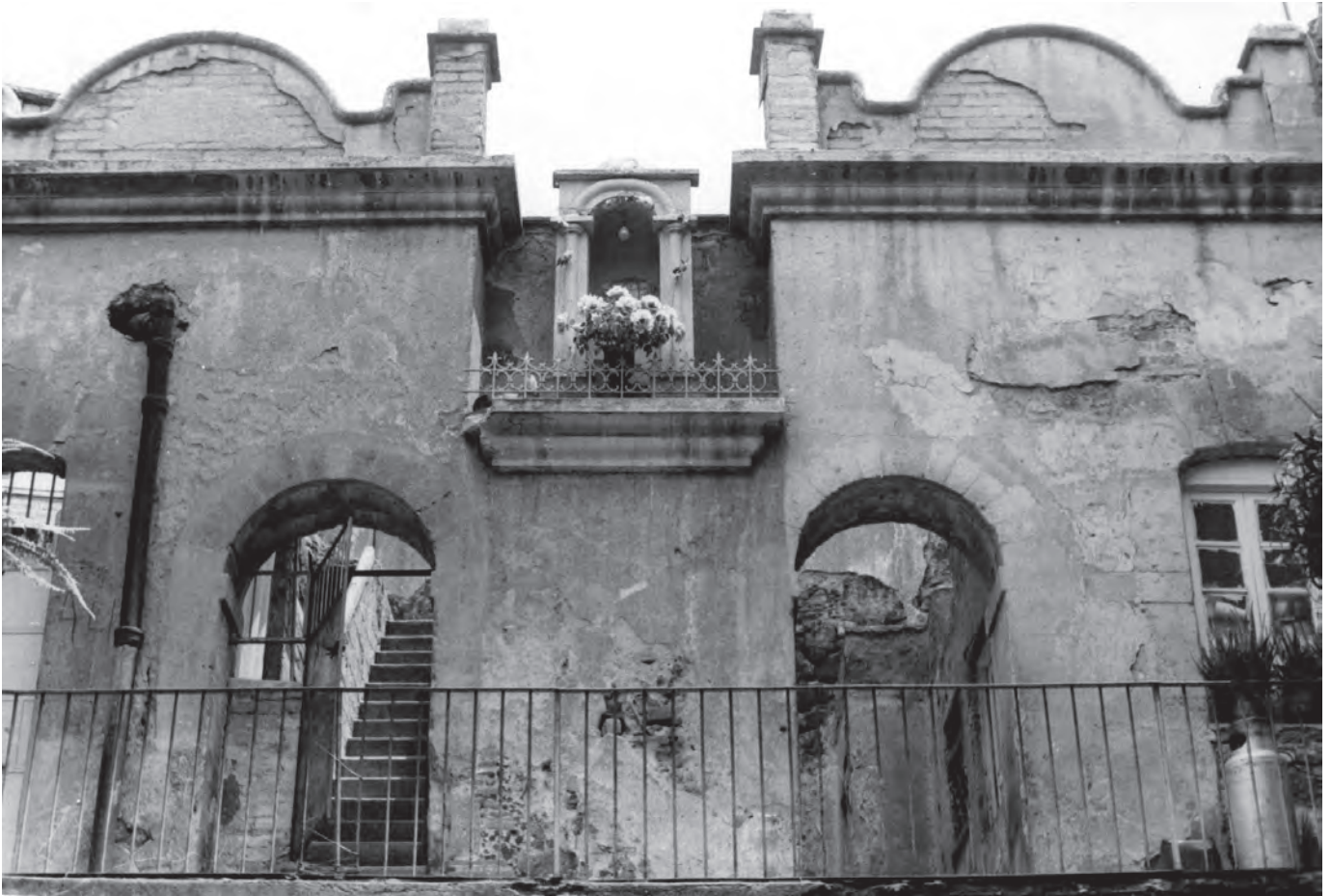
Interior, calle República de Bolivia núm. 58 Fotografía JARLO, 1970-1974
