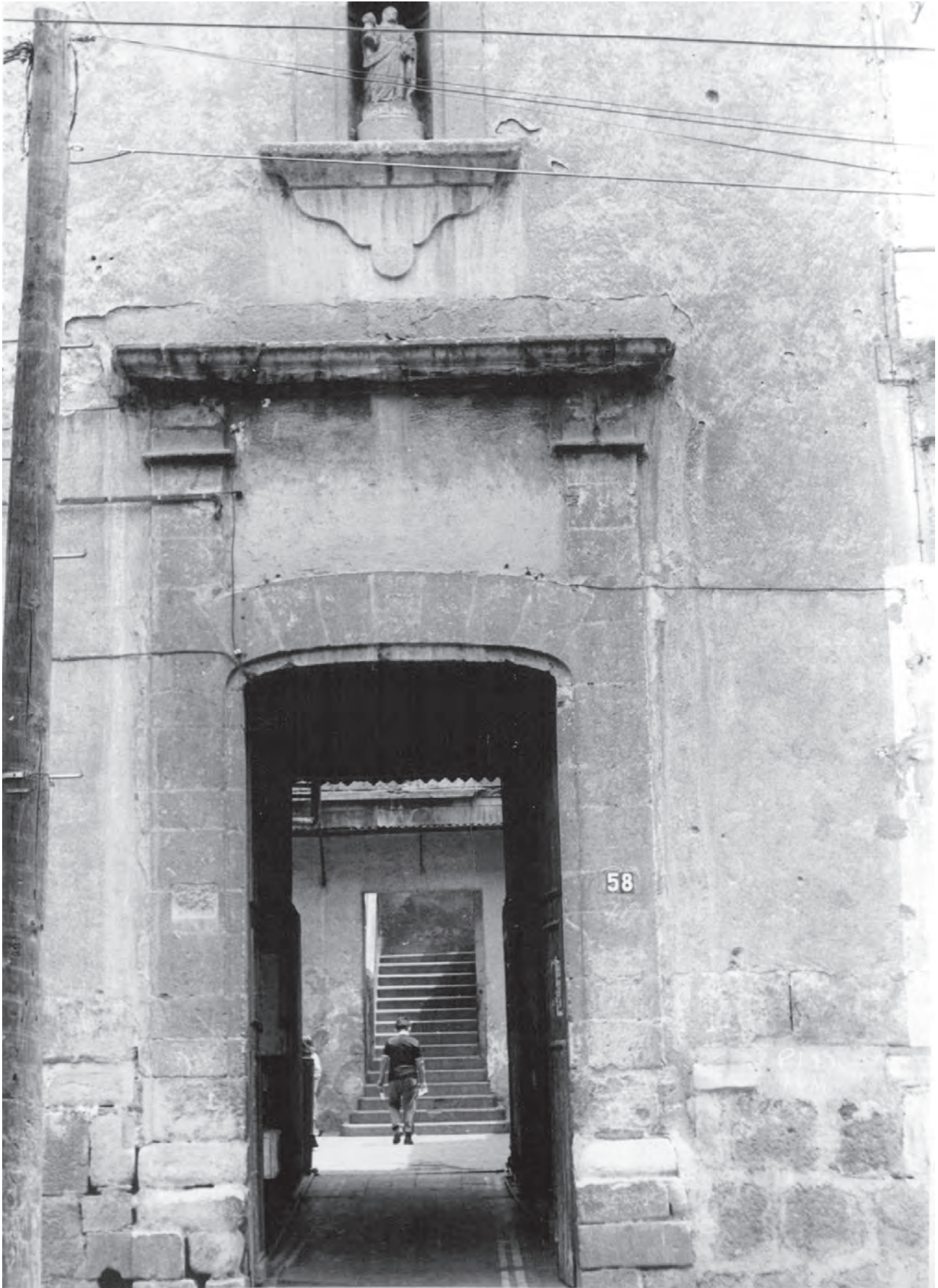
Fachada, calle República de Bolivia núm. 58 Fotografía JARLO, 1970-1974
