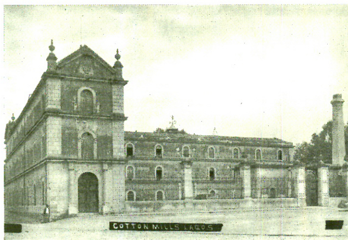
Winfield Scott, ca. 1905, fachada principal de la Industrial Cotton Mills , en Lagos de Moreno, Jal. Fototeca Nacional, CNCA-INAH.
