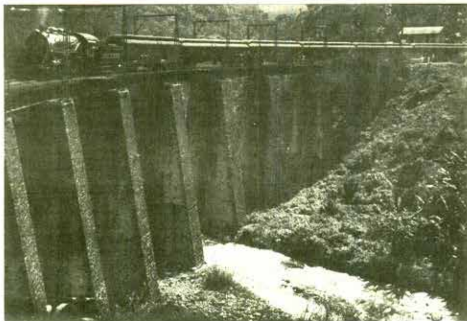
Sin identificar, ca. 1890, Puente de mampostería y estructura metálica para el Ferrocarril Central Mexicano. Barranca de Metlac, Ver. Fototeca Nacional, CNCA-INAH.
