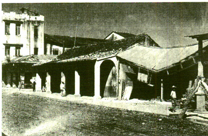
Daños en la calle principal y el Hotel Pacheco, Tuxtepec, Oaxaca, en 1944.
