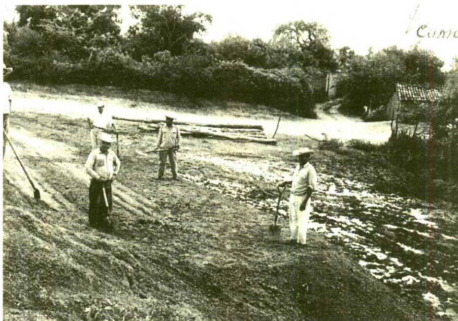
Terrecerías para tapar filtraciones en Cumuato, Michoacán.
