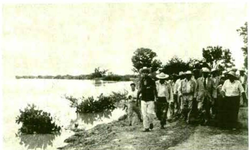
Inspección del Gobernador de Michoacán por el bordo izquierdo del paso Álamos, Michoacán.
