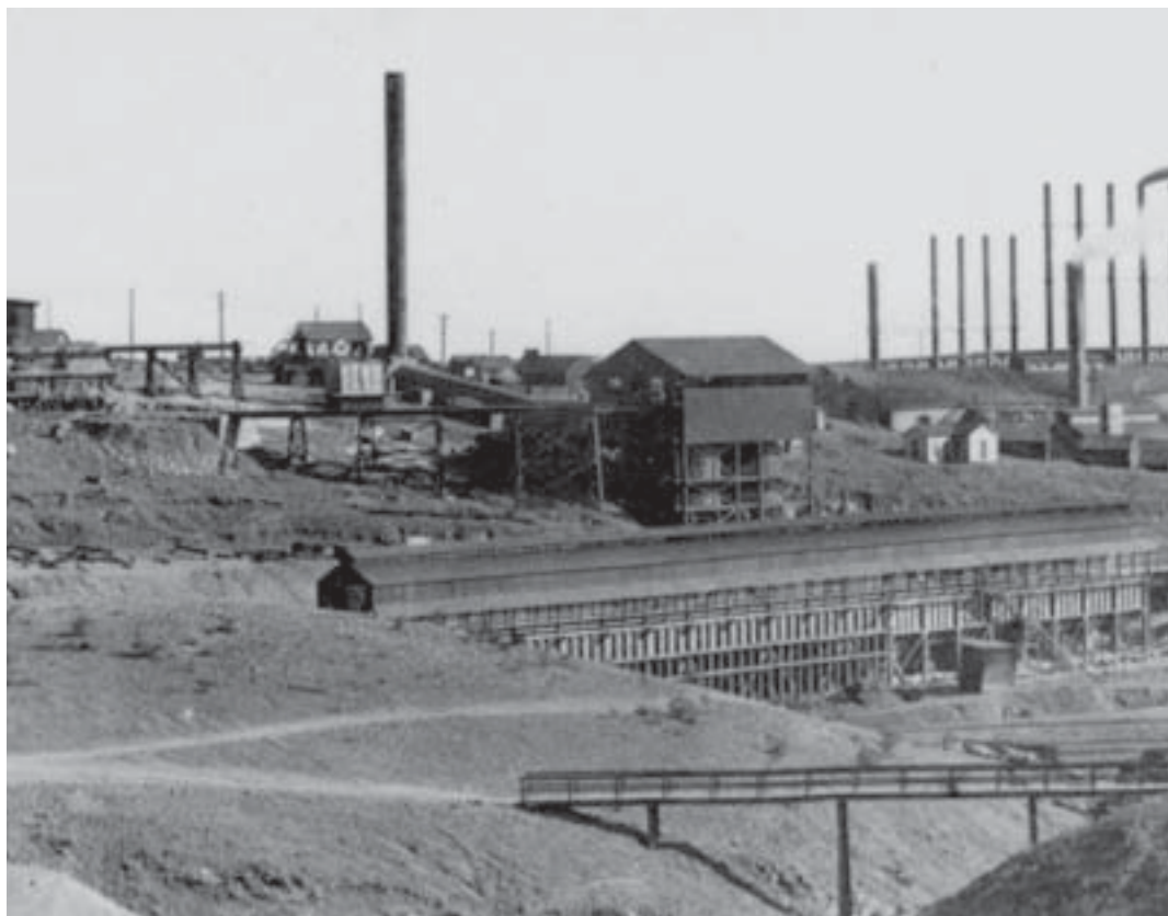
Panorámica de la Fundición, Casa de Fuerza, Casa de Bandas de metales, tubería para humo de los calderos y tostadores,
