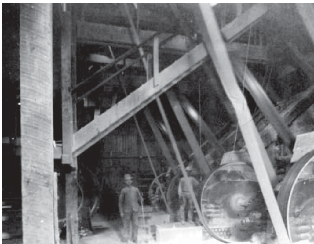
Quebradora de metales que se distribuyen por medio de las bandas, 1904, Cananea, Sonora. ©Coordinación Nacional de Museos y Exposiciones.
