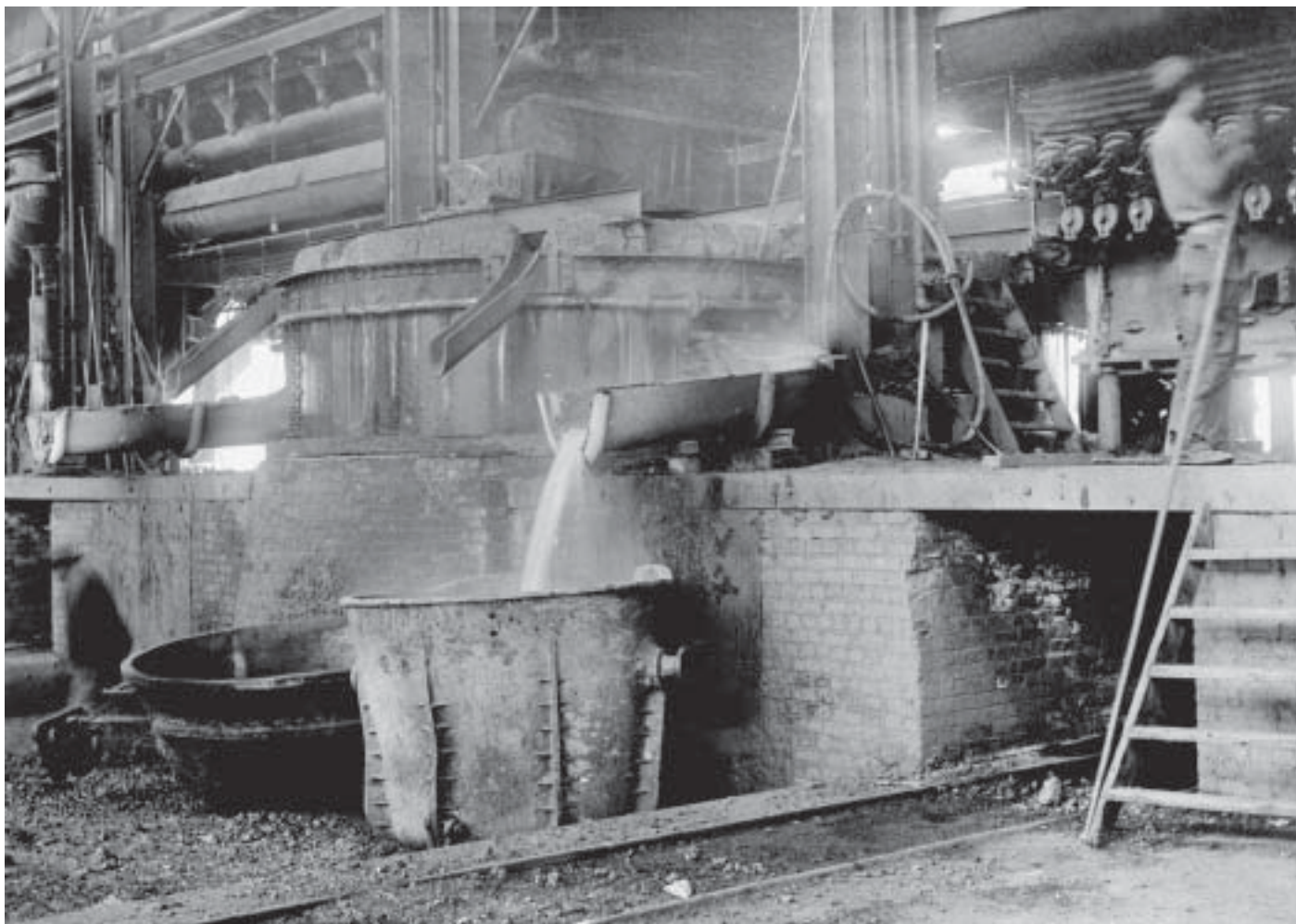
Salida del metal fundido de los hornos para ser transportado a las refinadoras y después ser vaciado a los moldes para sacar las barras que saldrán embarcadas fuera de Cananea, 1904. ©Coordinación Nacional de Museos y Exposiciones.
