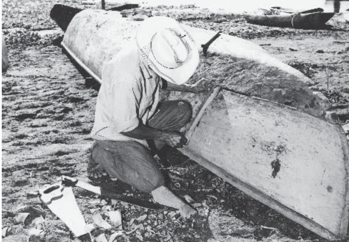
Nacho López, Pescador construyendo una canoa, Costa de Pacífico, 1960 © SINAFO-Fototeca Nacional.
