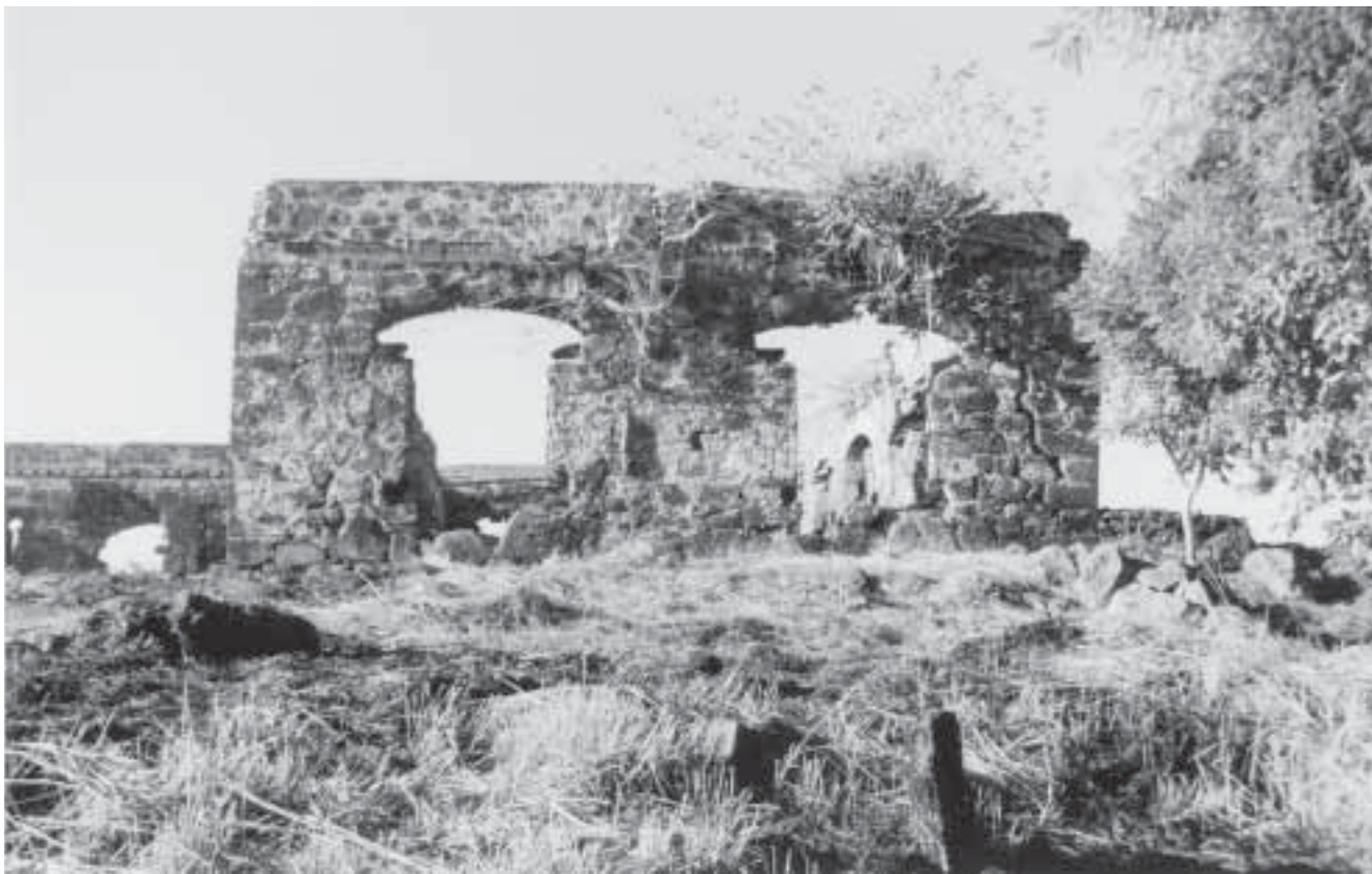
Fachada oriente de los almacenes de la Contaduría del puerto, villa de cerro San Blas, Nayarit. © Hugo Arciniega.
