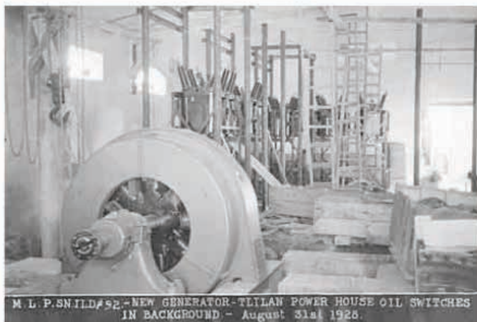
Interior de la casa de fuerza en Tlilan, 1928. Fototeca de Luz y Fuerza del Centro. Archivo Histórico.
