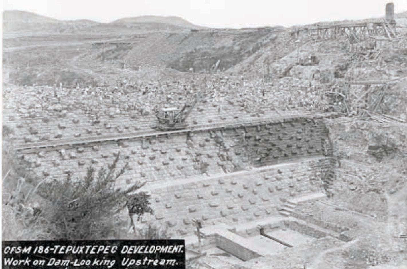
La mano del hombre se impone ante la naturaleza. Proceso constructivo de Tepuxtepec, Michoacán, 1928. Fototeca de Luz y Fuerza del Centro. Archivo Histórico.
