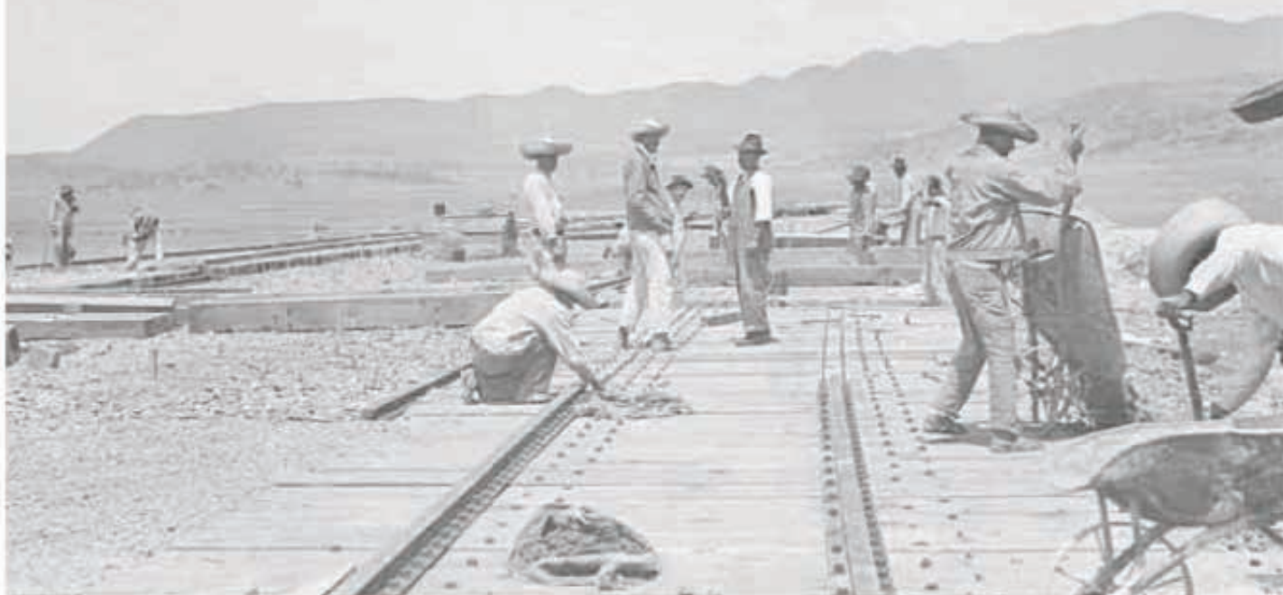
Avances en el tendido de la vía de ferrocarril, kilómetro 58. Tepuxtepec, Michoacán, 1928.
