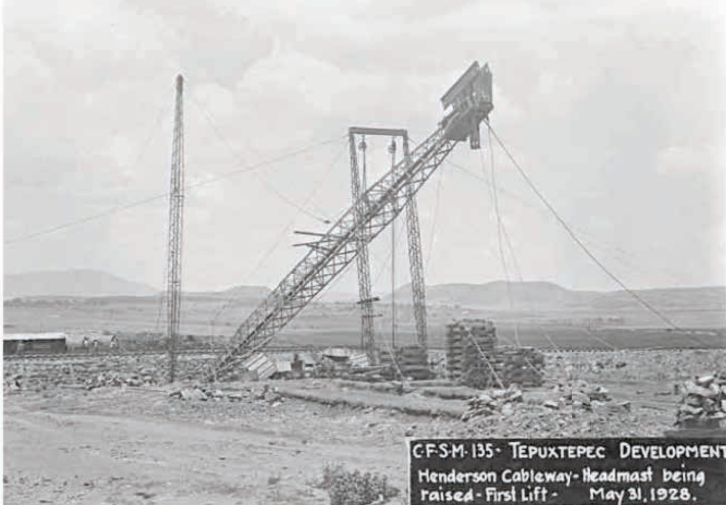
Un reto de la ingeniería. Proceso constructivo de Tepuxtepec, Michoacán, 1928. Fototeca de Luz y Fuerza del Centro. Archivo Histórico.
