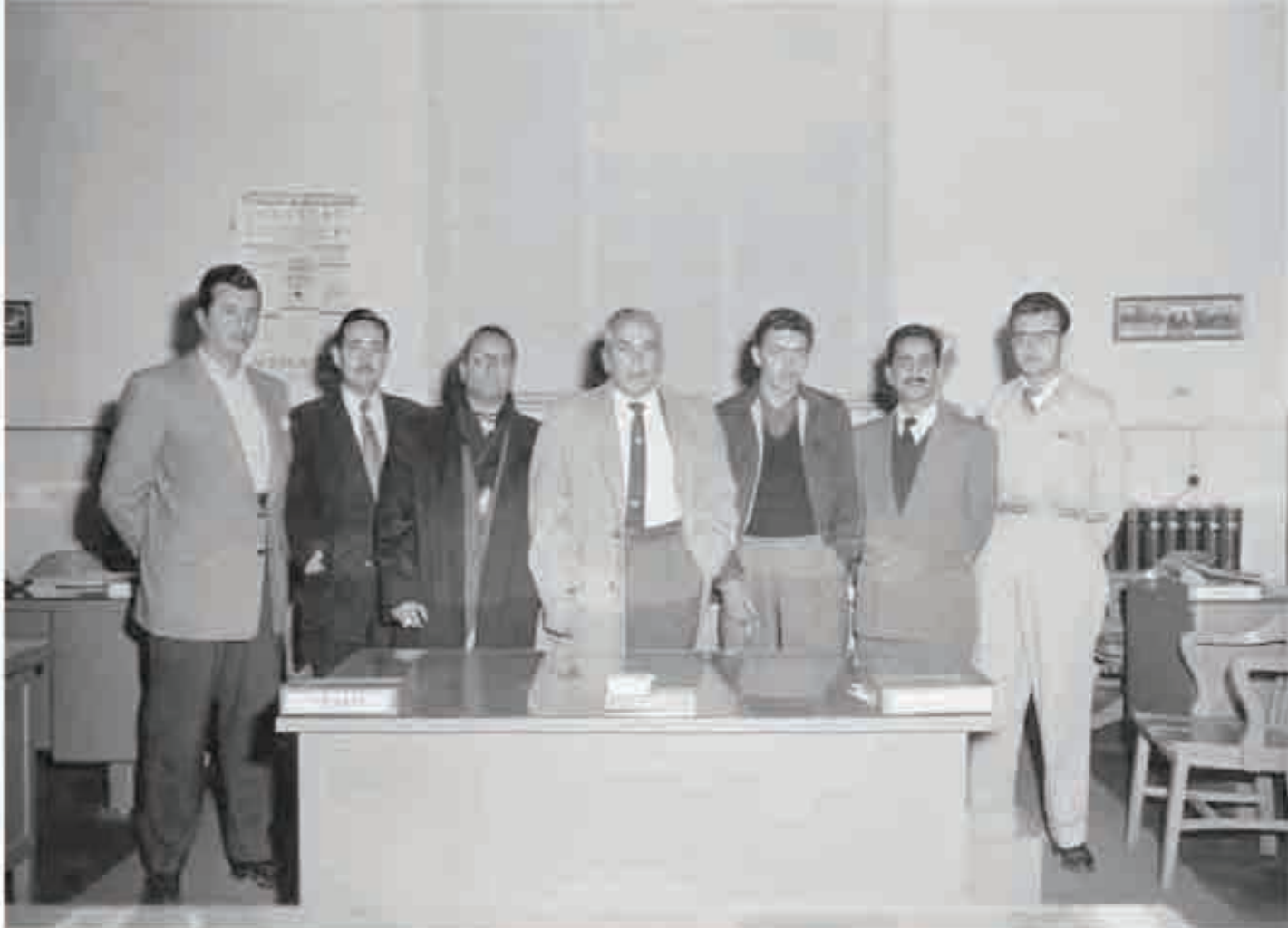
Al interior del Taller de Transformadores Verónica y personal de oficina del mismo centro de trabajo. Co., 1955. Fotografía de Luz y Fuerza del Centro. Archivo Histórico.
