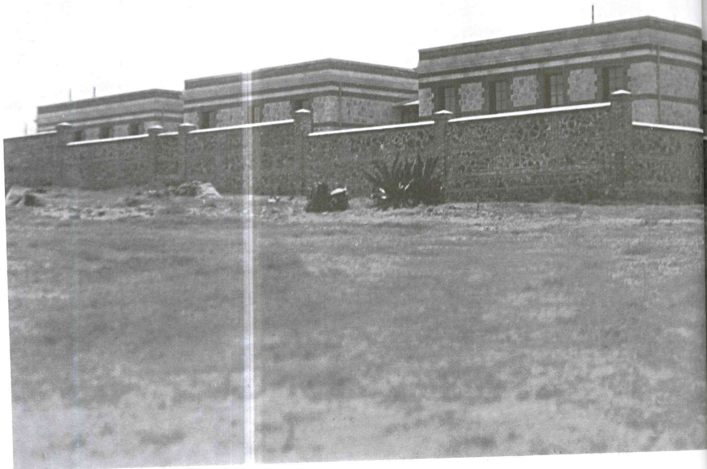
Muro que rodeaba al Manicomio General
