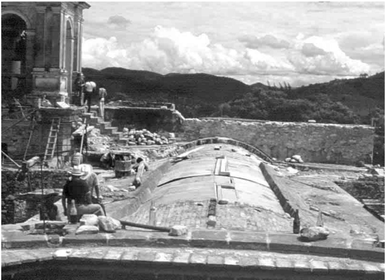
Xochihuehuatlán. Restauración de la bóveda de cañón del templo
