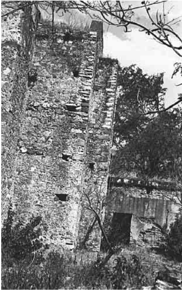
Coyahuaco, Municipio de Huamuxtlán, muros y contrafuertes del Templo en ruinas.
