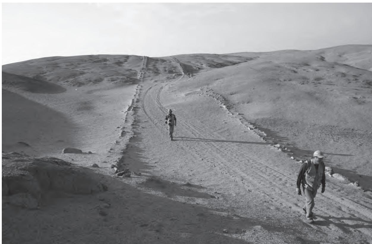
**Figura 2** Sección de camino costero delimitado por muros de piedras a ambos lados **Fotografía** Archivo Proyecto Qhapaq Ñan, Ministerio de Cultura, en línea [<http://www.qhapaqnan.gob.pe/wordpress/?p=1990>]
