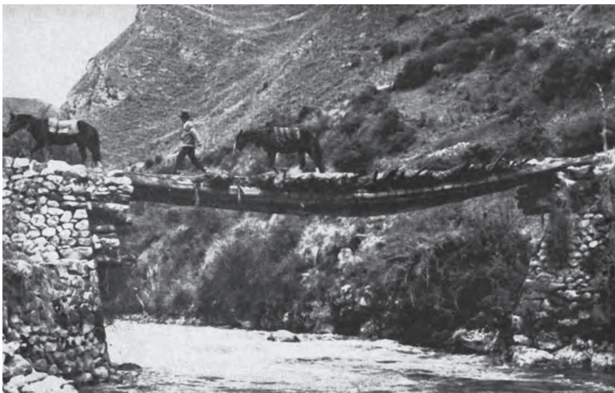
**Figura 4** Puente de troncos sobre bases de piedra en Huánuco **Fotografía** Thompson y Murra, 1980
