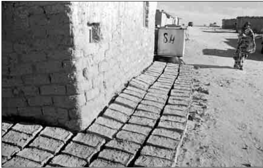
Reconstruyendo las casas destruidas. Calle principal del campamento de refugiados saharauis "27 de Febrero", región de Tinduf, Argelia, marzo de 2006. Foto: Ricardo Ramírez Arriola.
