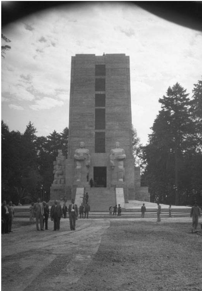
Visita presidencial a la obra del Monumento a Álvaro Obregón. En primer plano el Parque de La Bombilla. 28 de noviembre de 1934. Fototeca Nacional del INAH. Fondo Casasola, 92773.
