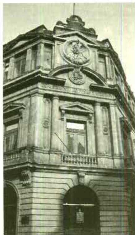
Edificio del Departamento de Pesas y Medidas, Arq. Genaro Alcorta, 1904, actualmente representación estatal del Estado de Nuevo León. Foto: Hugo Arciniega.
