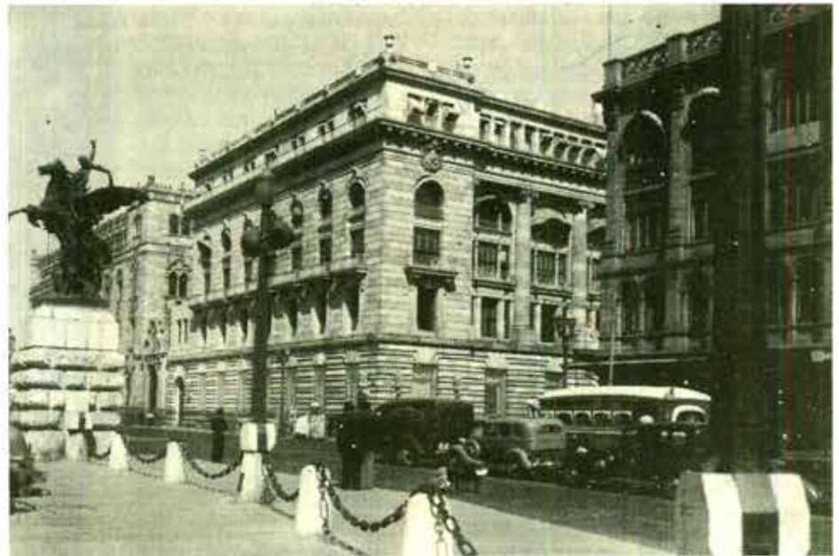
Palacio Postal y La Mutua, transformada en Banco de México. Foto: La Rochester, hacia 1930.
