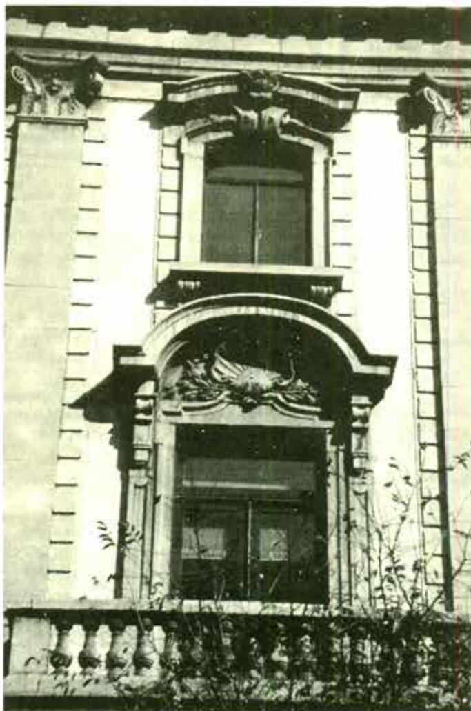
Orden colosal en el No. 20 de la Avenida del 5 de Mayo. Foto: Hugo Arciniega.
