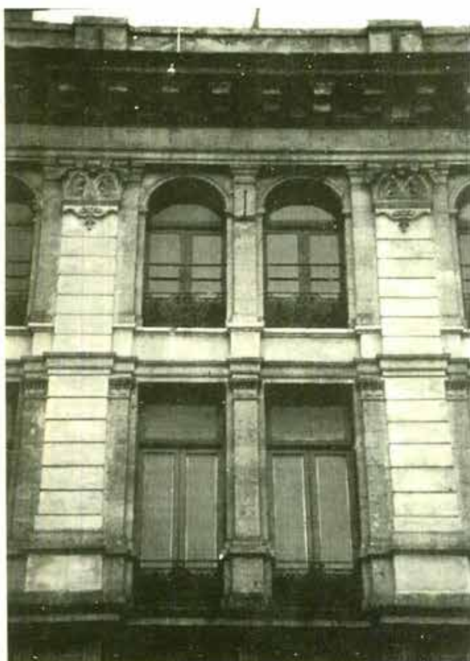
Orden colosal en el No. 13 de la Avenida del 5 de Mayo. Foto: Hugo Arciniega.
