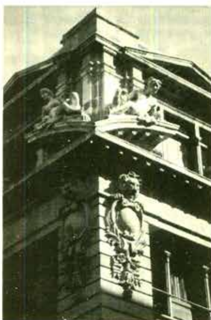
Edificio de los Ferrocarriles Nacionales de México, Arq. Isidro Díaz Lombardo, 1908. Foto: Hugo Arciniega.
