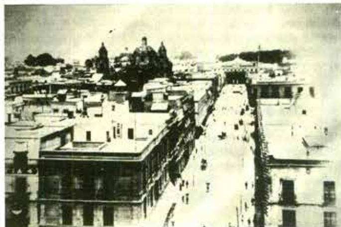
Regularización del alineamiento en la Avenida del 5 de Mayo.
