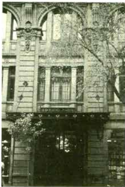
Acceso al edificio París, Avenida del 5 de Mayo No. 32. Foto: Hugo Arciniega.
