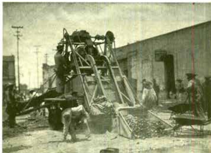
Sin identificar, 1920, Sustitución de los empedrados en las calles de la Ciudad de México, revolvedora en funcionamiento. Fototeca Nacional, CNCA-INAH.
