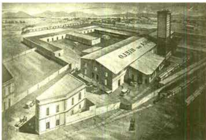
Sin identificar, ca. 1890, Frigorífico y edificios administrativos en la Fábrica de Hielo, Ciudad de México. Fototeca Nacional, CNCA-INAH.
