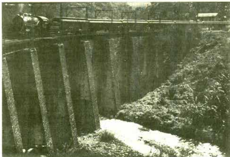
Sin identificar, ca. 1890, Puente de mampostería y estructura metálica para el Ferrocarril Central Mexicano. Barranca de Metlac, Ver. Fototeca Nacional, CNCA-INAH.
