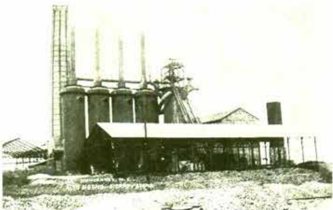
Sin identificar, 1940, Alto horno en la Fundición de Hierro y Acero , Monterrey N. L. Fototeca Nacional, CNCA-INAH.
