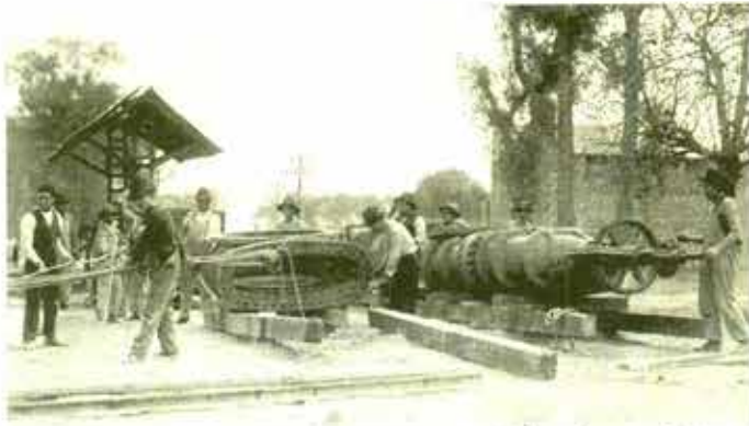
Sin identificar, 1910, Armado de vía, Ciudad de México. Fototeca Nacional, CNCA-INAH.
