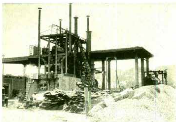
Sin identificar, 1920, Estructura metálica de una calera, Ciudad de México. Fototeca Nacional, CNCA-INAH.
