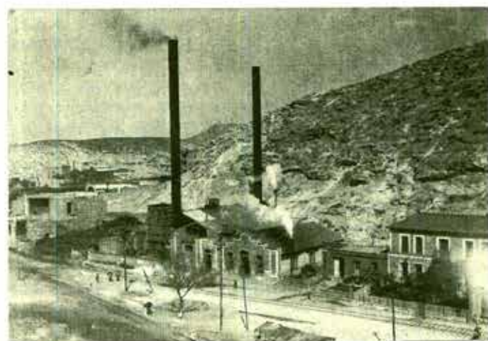
Sin identificar, ca. 1910, Fundición de Hierro y Acero, Torreón, Coahuila . Se aprecia la influencia de la arquitectura norteamericana sobre todo en el tratamiento de los áticos. Fototeca Nacional, CNCA-INAH.
