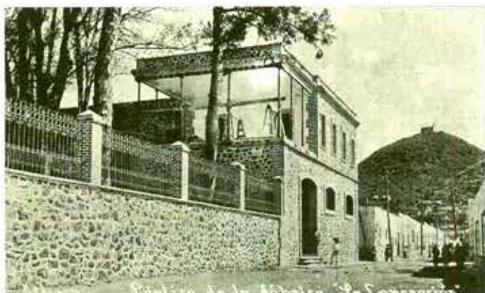
Sin identificar, ca. 1910, Pórtico de la fábrica La Concepción, Atlixco, Pue. Los apoyos metálicos importados permitían salvar claros más extensos. Fototeca Nacional, CNCA-INAH.
