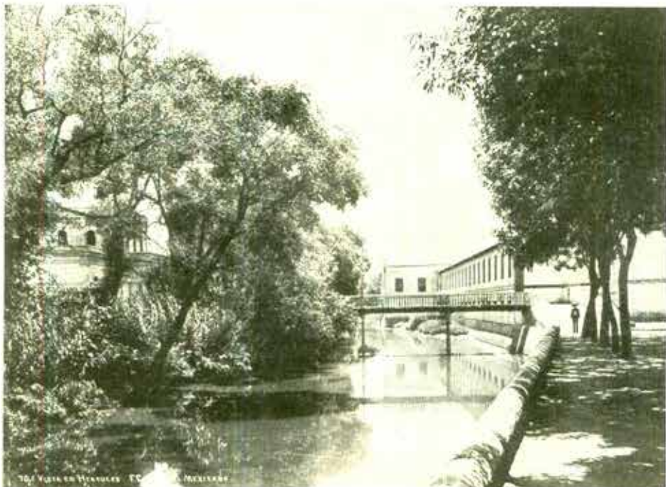
Gove & North, ca. 1885, Vista de la Fábrica Hércules. F.C. Central Mexicano. Puente sobre el canal de derivación, Querétaro, Qro. Fototeca Nacional, CNCA-INAH.
