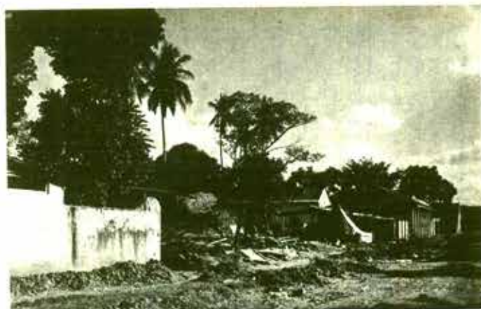
Daños de la inundación en Tuxtpec, Oaxaca en 1944.
