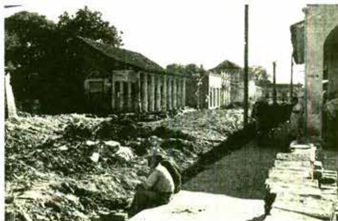
Pobladores observando los daños en Tuxtepec, Oaxaca.
