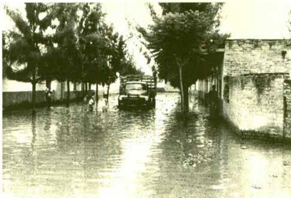
Calle de Briseñas Michoacán inundada.
