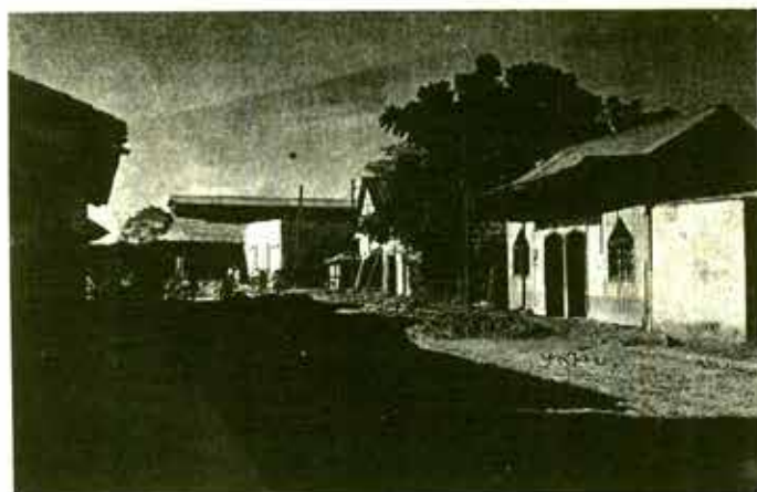
Daños en Tuxtepec, Oaxaca en 1944, por la inundación.
