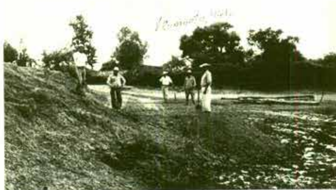
Terrecerías para tapar filtraciones en Cumuato, Michoacán.
