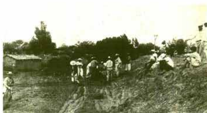
Reforzamiento de bordos en Cumuato, Michoacán.
