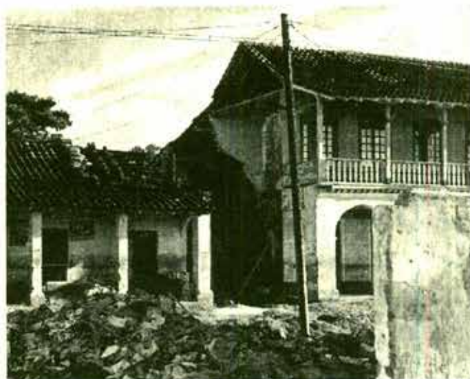
Daños de la inundación en Tuxtepec, Oaxaca en 1944.
