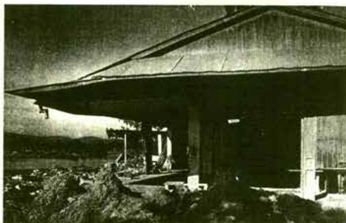
Daños a la orilla del río Papaloapan en Tuxtepec, Oaxaca, por las inundaciones en 1944.
