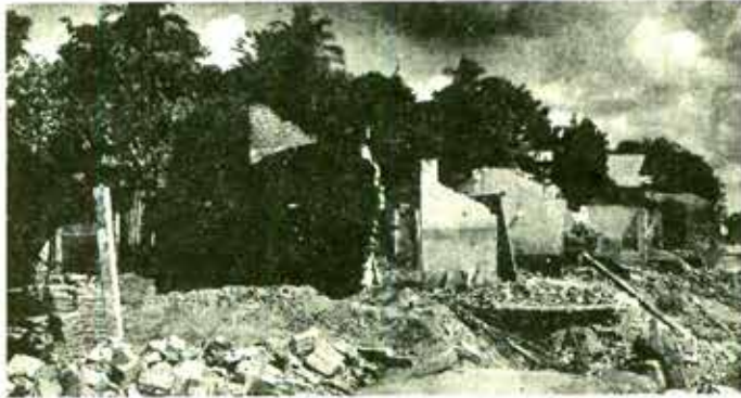
Daños de la inundación en Tuxtepec, Oaxaca en 1944.
