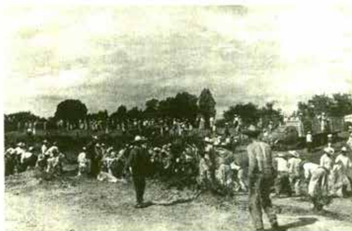
Trabajo de reforzamiento de un bordo izquierdo del río Lerma, 900 metros abajo del paso de Álamos Michoacán.
