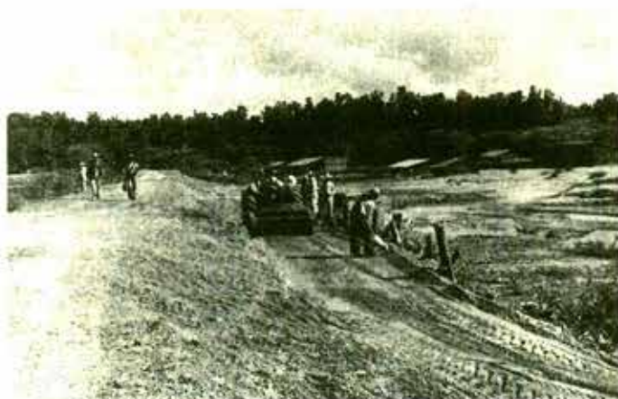
Reforzamiento del bordo izquierdo del río Lerma del río Lerma.
