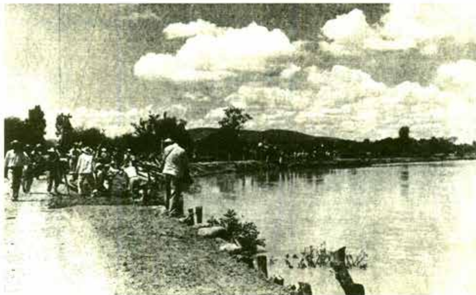
Colocación del estacado para evitar erosión en el bordo izquierdo del río Lerma.
