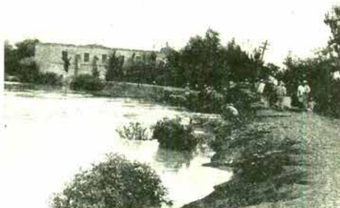
Estancando de protección en el bordo del río Lerma en Cumuato. Michoacán.
