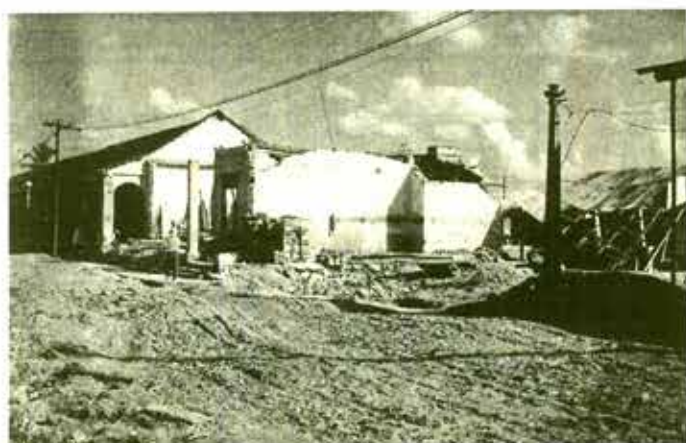
Daños en Tuxtpec, Oaxaca, después de las inundaciones en 1944.
