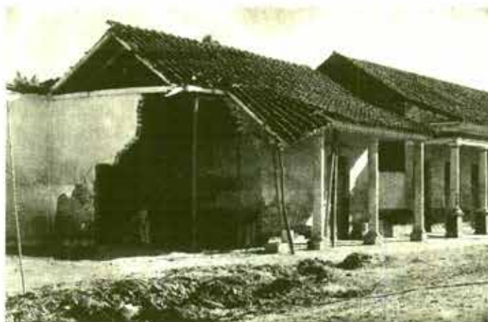
Daños en Tuxtepec, Oaxaca, después de las inundaciones en 1944.
