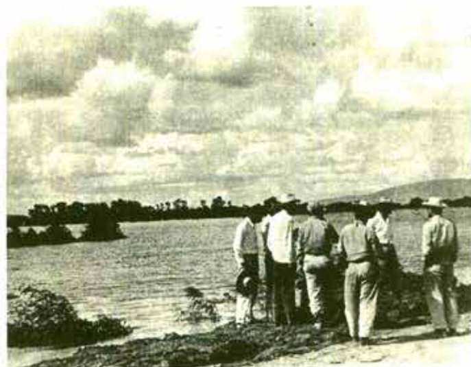
Daños en Tuxtepec, Oaxaca en 1944, por la inundación.
