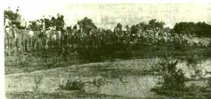
Trabajos de reforzamiento del río Lerma al margen izquierdo, abajo del Paso de Álamos, Michoacán.
