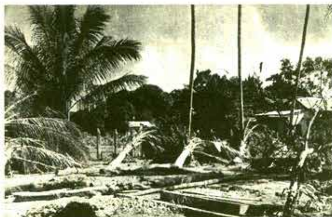
Daños de la inundación en Tuxtepec, Oaxaca en 1944.
