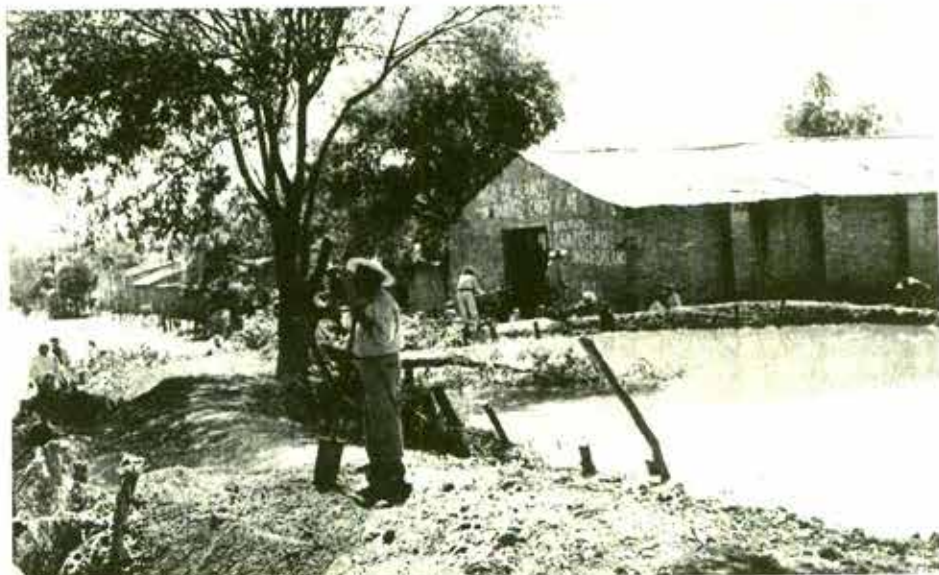
Álamos, Michoacán. Reforzamiento de bordos para evitar que el agua entre a las casas.
