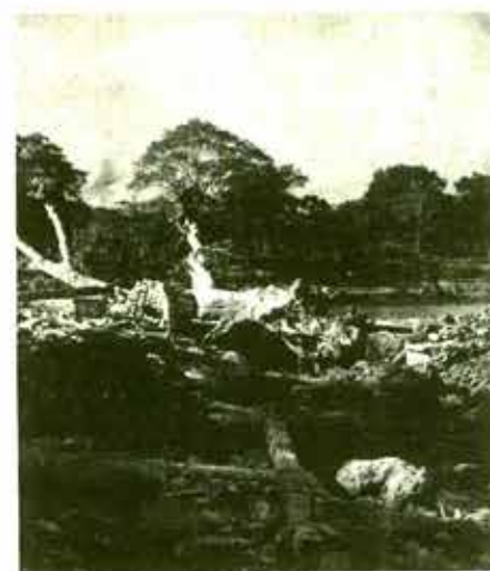
Daños de la inundación en Tuxtpec, Oaxaca en 1944.
