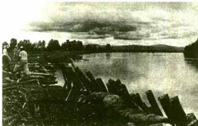
Reforzamiento del bordo izquierdo del río Lerma. Briseñas, Michoacán.
