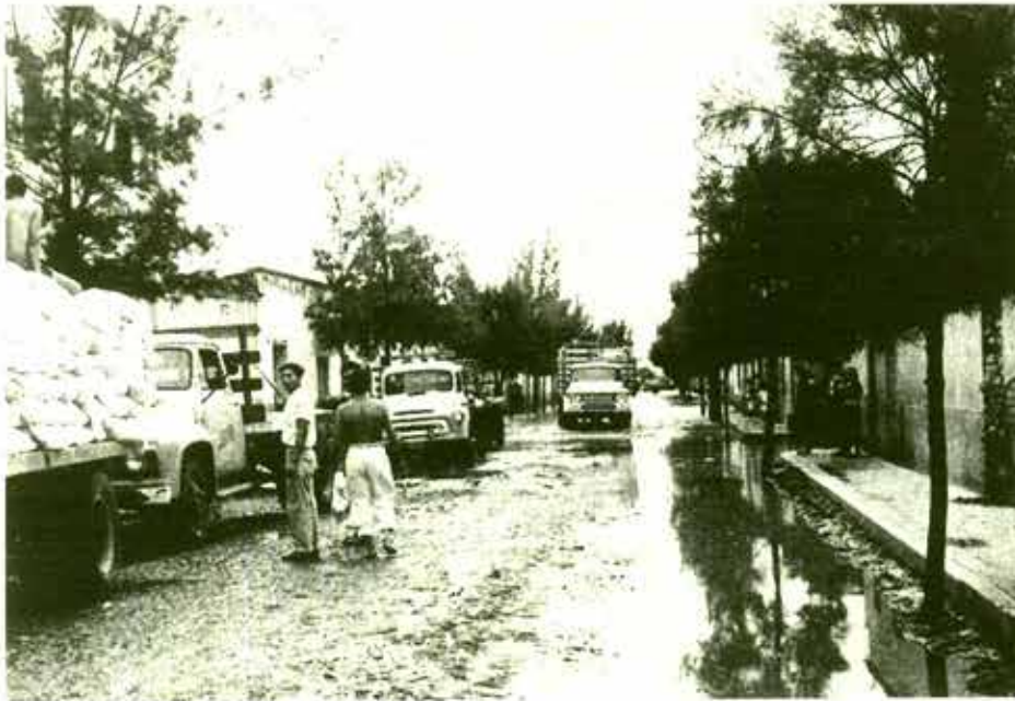
Calle de Briseñas, Michoacán, después de la inundación.
