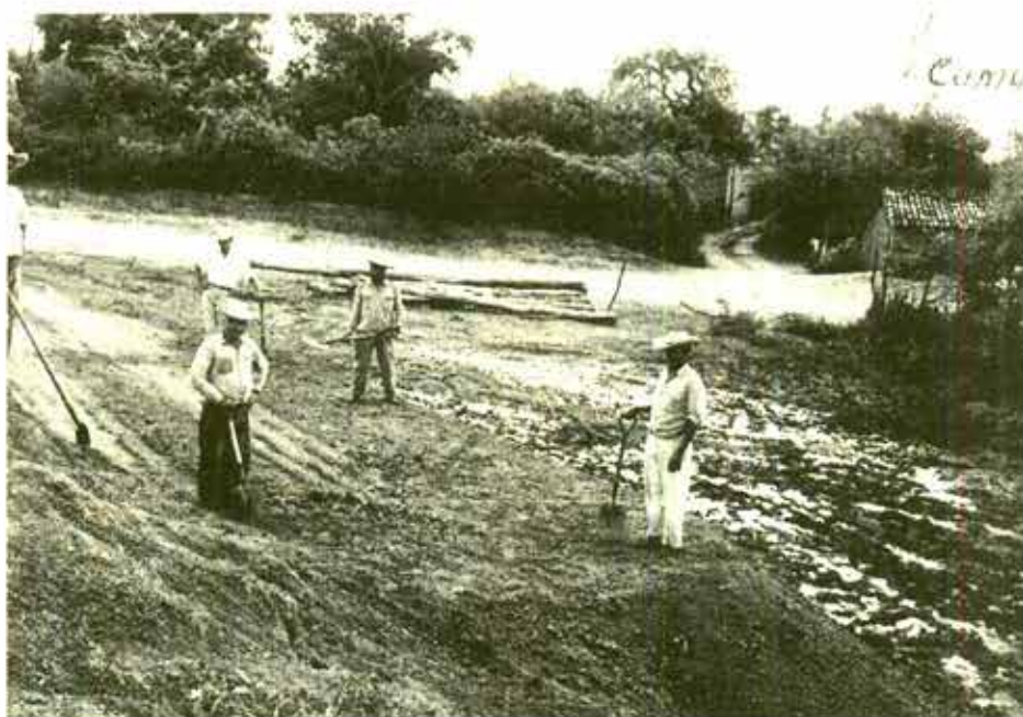
Terrecerías para tapar filtraciones en Cumato, Michoacán.
