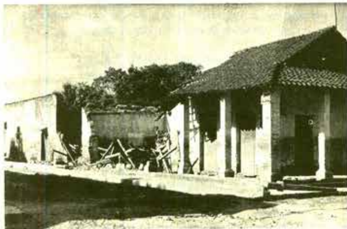
Daños en Tuxtepec, Oaxaca en 1944, por la inundación.
