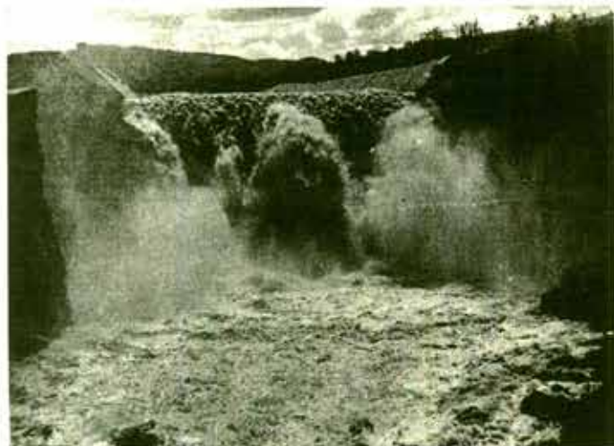
Presa Solís. Descarga de excedencia, visto aguas abajo.
