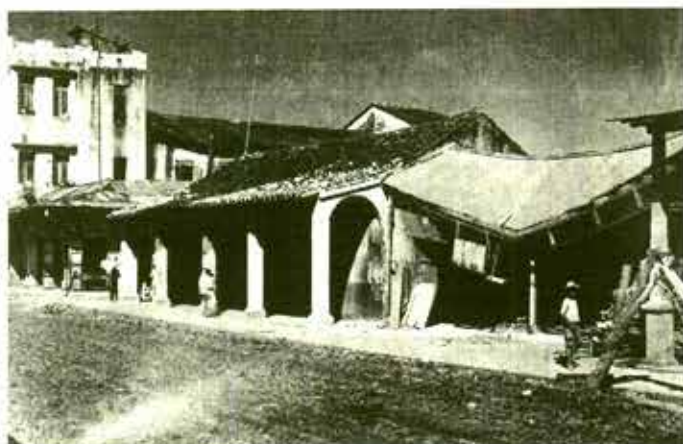
Daños en la calle principal y el Hotel Pacheco, Tuxtpec, Oaxaca, en 1944.
