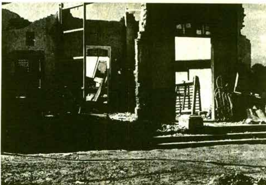
Daños en Tuxtepec, Oaxaca en 1944, por la inundación.
