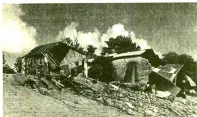
Daños en Tuxtepec, Oaxaca en 1944, por la inundación.
