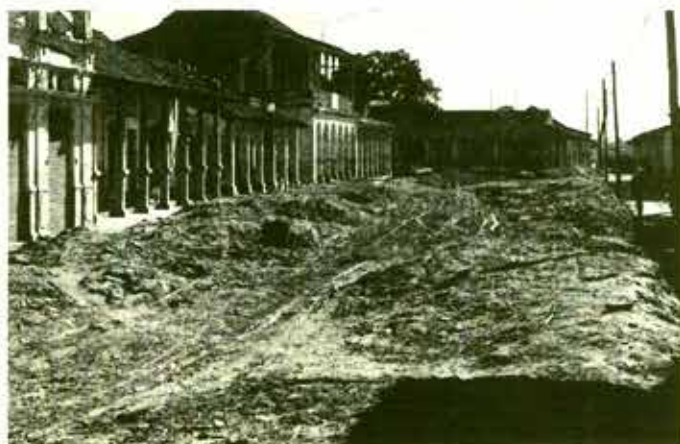
Daños en la calle principal de Tuxtepec, Oaxaca en 1944.
