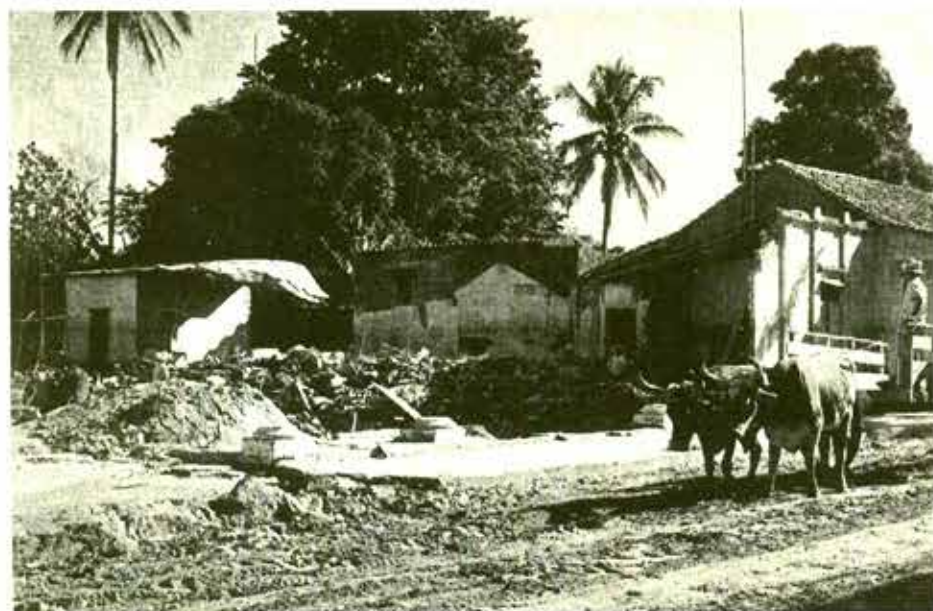
Daños en Tuxtpec, Oaxaca en 1944, por la inundación.
