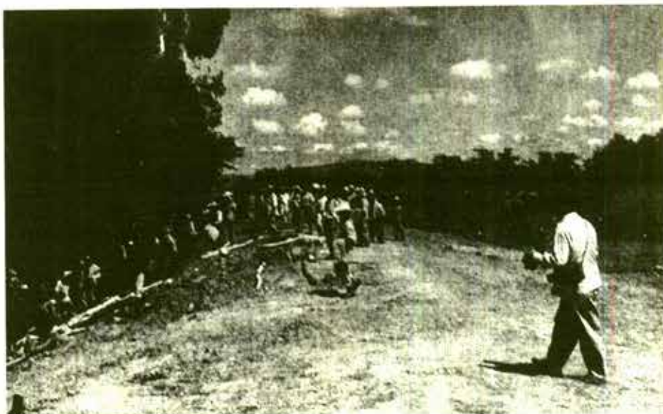
Tapando Filtraciones y reforzamiento del bordo Izquierdo del río Lerma.
