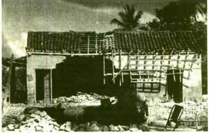
Daños de la inundación en Tuxtepec, Oaxaca en 1944.
