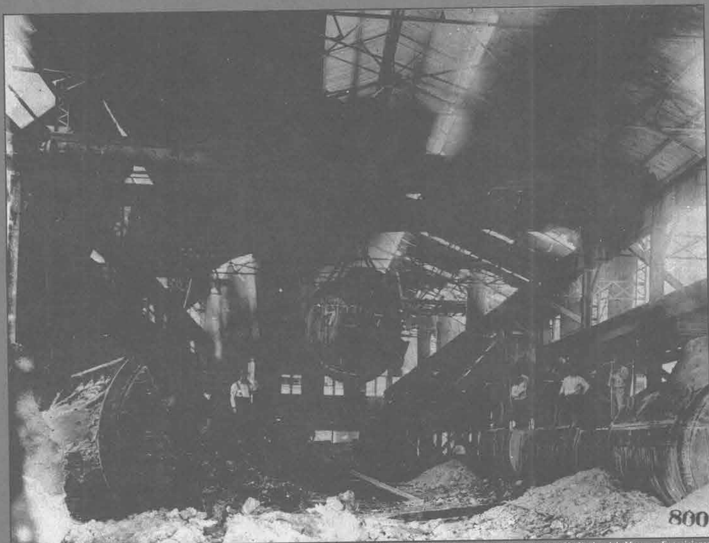
Interior de la Fundición y movimiento de las grúas para cargar refinadoras y mover cobre ya fundido a los moldes de embarque, 1904. © Coordinación Nacional de Museos y Exposiciones.
