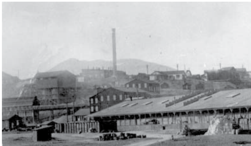
(foto superior) Taller mecánico, fundición de Hierro y Taller Eléctrico de la compañía Minera, 1904, Cananea, Sonora.
