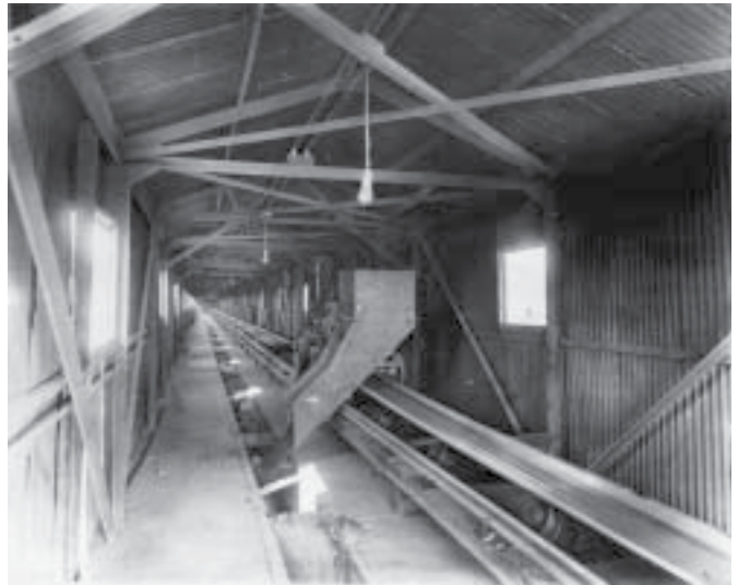
Banda transmisora arriba de los hornos de la Fundición, 1904, Cananea, Sonora. ©Coordinación Nacional de Museos y Exposiciones.
