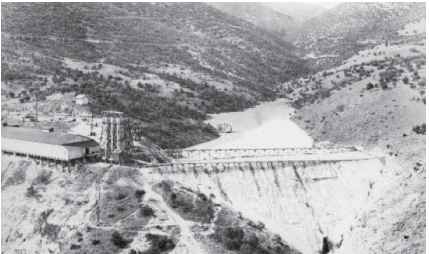
Casa de la concentradora número 3 con los elevadores de arenas sin valor, dando frente al oriente, 1908, Cananea, Sonora. ©Coordinación Nacional de Museos y Exposiciones.
