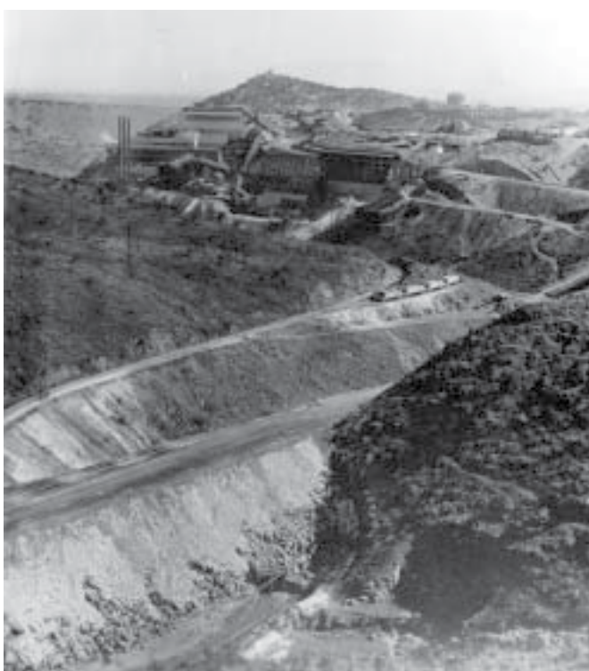
Panorámica de la Concentradora y tanque de almacenamiento de agua dulce o potable, viendo hacia el noreste. Abajo tanque del ferrocarril de vía angosta de la compañía. Con metal concentrado para ser llevado a la Fundición, 1908, Cananea, Sonora. ©Coordinación Nacional de Museos y Exposiciones.
